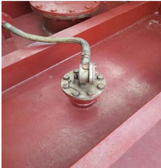
\* Sistema de accionamiento alarma por alto nivel de producto en tanque. Fuente: Autor.
