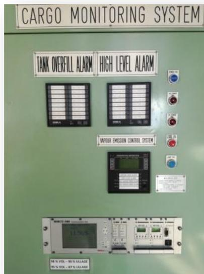
\* Repetidor y panel principal de alarmas de alto nivel de producto en tanque. Fuente: Autor.
