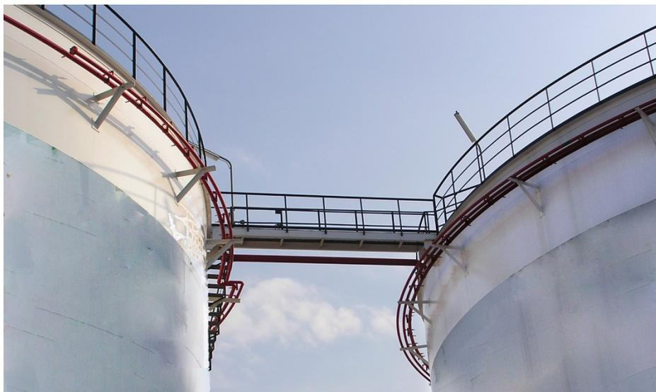
*Figura 2.- Ejemplo de disposición de anillos rociadores. (Fuente: Elaboración propia)*
