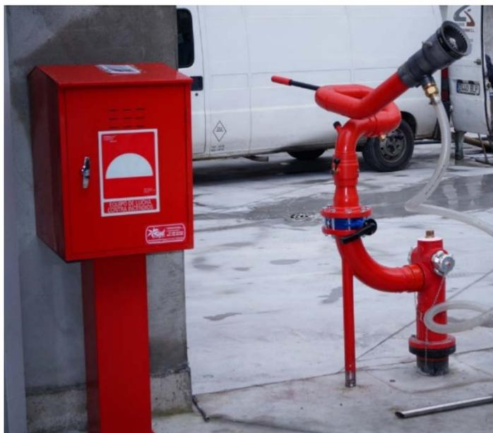
*Figura 6.- Hidrante con Monitor y Armario de Equipo Auxiliar (Fuente: Catálogo Integra Seguridad protección y Control).*
