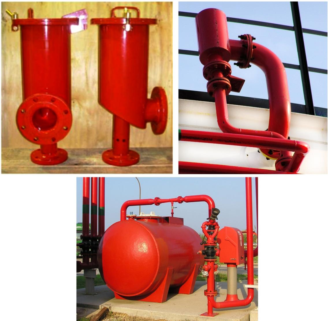
*Figura 4.- Cámara de Espumógeno MCS-9 y depósito de espumógeno (Fuente: Elaboración propia)*
