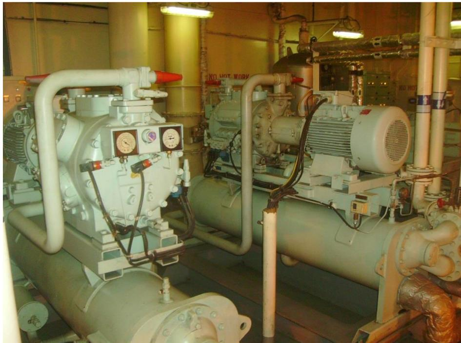
*Imagen 17: Planta de refrigeración de aire acondicionado. Fuente: [ingmaritima.blogspot.com.es](http://ingmaritima.blogspot.com.es)*
