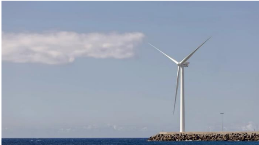
Figura 90: Prototipo del aerogenerador Gamesa G128-5.0MW Offshore instalado en el muelle de Arinaga (Islas Canarias, España) [59]
