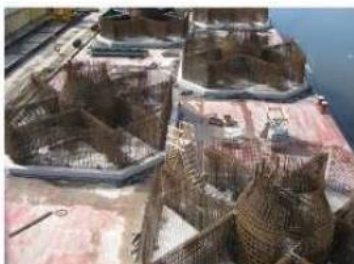
Montaje del encofrado de acero
