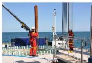
Se comprueba la nivelación
