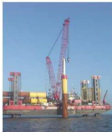
Descenso e hinca del pilote en el fondo.
