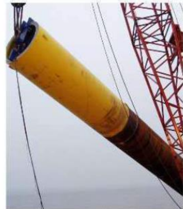
La grúa inicia el levantamiento del pilote.
