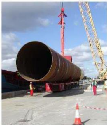
El monopilote llega a puerto.
