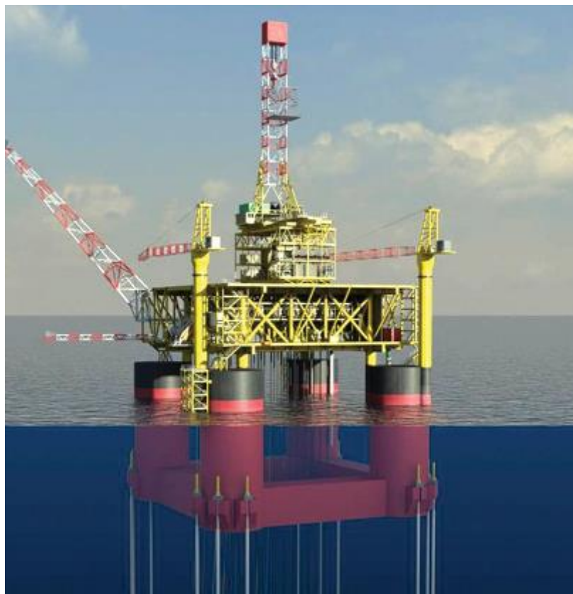
Figura 44: Esquema plataforma TLP Hyundai Heavy Industries (HHI) [27]
