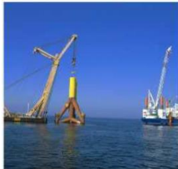
Elevación con grúa
