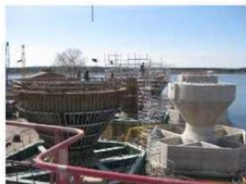
El encofrado se rellena de hormigón
