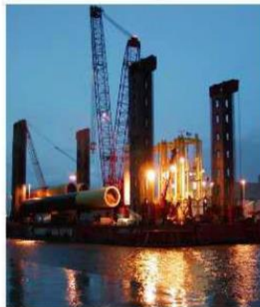
El monopilote es cargado en el buque.
