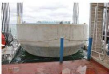
Descenso de la cimentación
