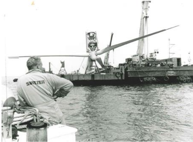
Figura 56: Instalación del parque eólico Vindeby, Dinamarca 1991 [34]
