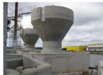
La estructura de gravedad esta lista
