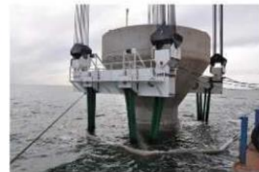
Las cimentaciones se posicionan
