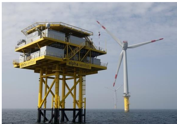
Figura 53: Subestación offshore parque eólico "alpha ventus" situada en el Mar del Norte [31]
