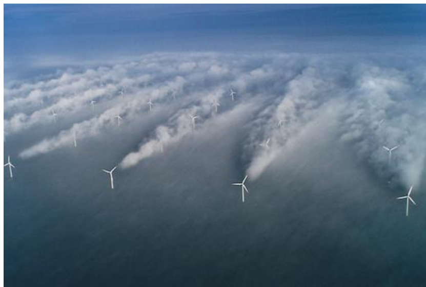
Figura 92: Efecto estela en el parque eólico offshore Horns Rev [61]
