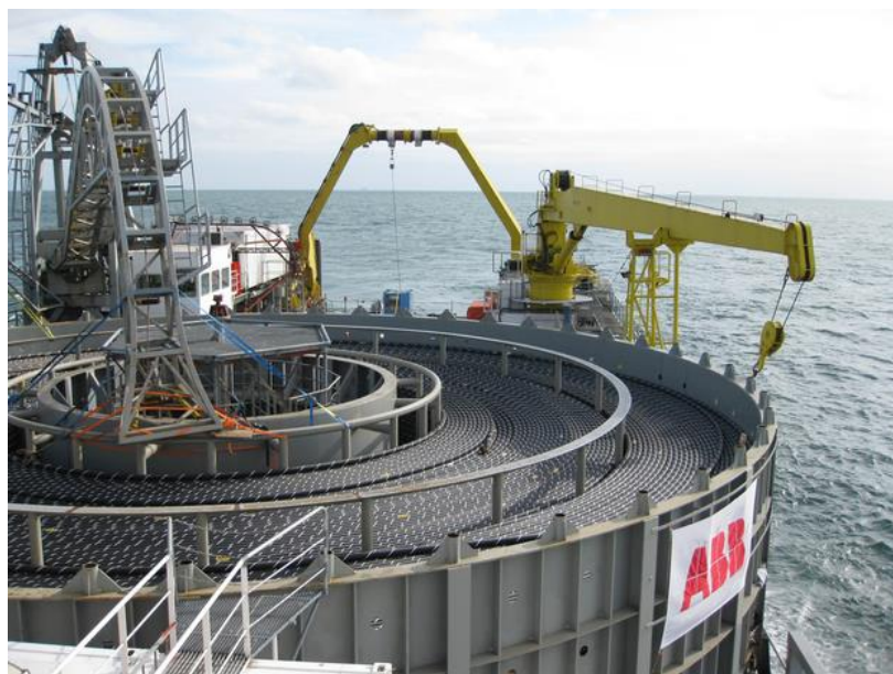
Figura 52: Barco para la instalación de cable submarino (en operación) [30]
