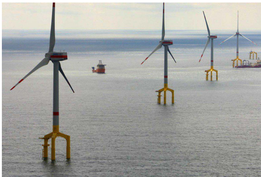
Figura 33: Parque eólico “BARD Offshore 1” (situado a una profundidad de 40 metros) [22]
