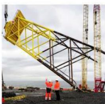
Fabricación de la estructura
