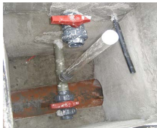
Figura 36: Conexión e instalación de arqueta de monitorización de las plazas de aparcamiento en el Parque Científico y Tecnológico de Gijón (Asturias)
