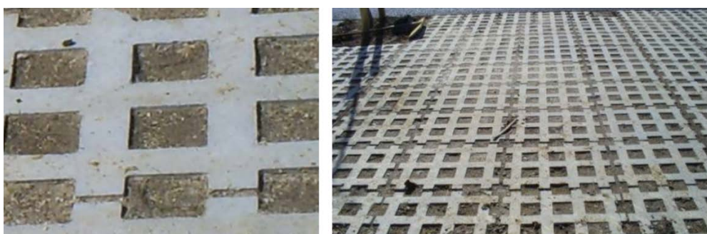
Figura 44. Celdas de hormigón utilizadas en el aparcamiento experimental [178]
