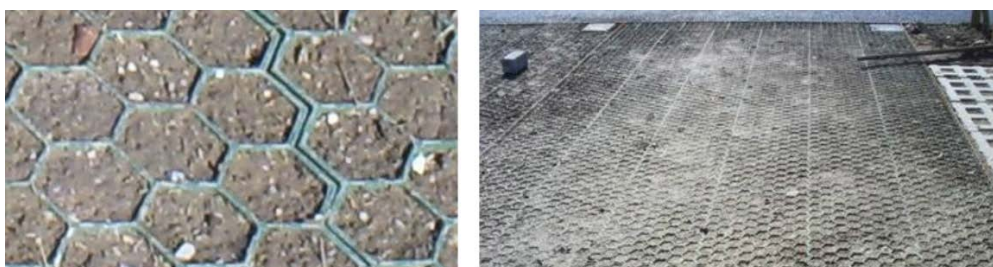
Figura 45. Celdas de plástico empleadas en el aparcamiento experimental de Las Llamas [178]
