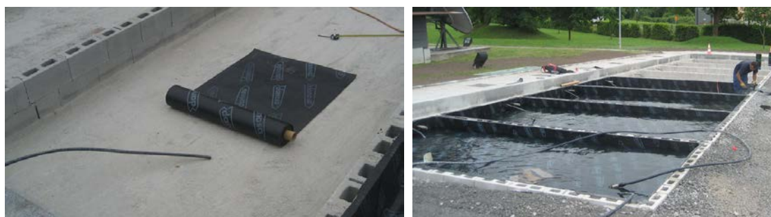
Figura 35: Impermeabilización de las plazas de aparcamiento y prueba de estanqueidad del aparcamiento experimental del Parque Científico y Tecnológico de Gijón (Asturias)
