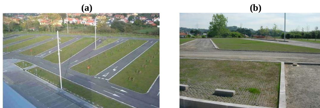
Figura 28: Aparcamiento del Palacio de los deportes de La Guía (Gijón)
