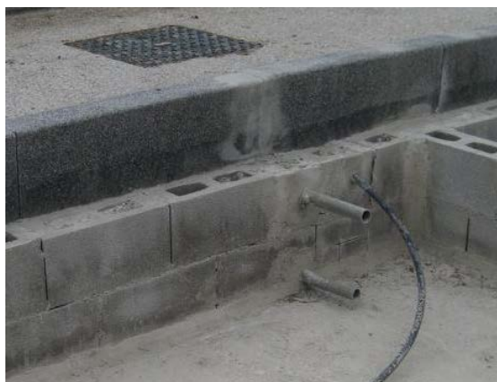
Figura 36: Conexión e instalación de arqueta de monitorización de las plazas de aparcamiento en el Parque Científico y Tecnológico de Gijón (Asturias)
