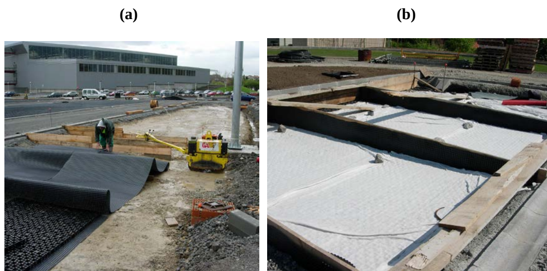
Figura 32: Lamina de impermeabilización empleada y su puesta en obra: (a) Geocompuesto alveolar y (b) Geotextil de protección
