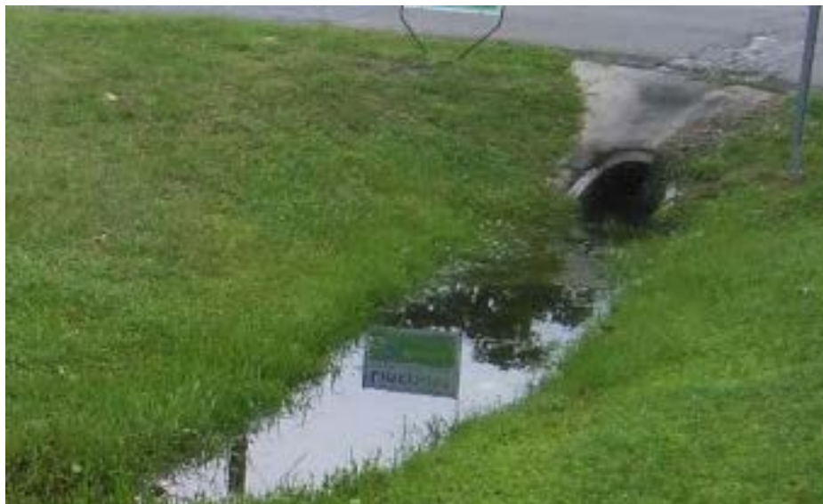
Figura 10: Cuneta verde mojada
