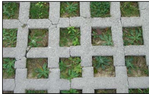
Figura 5: Césped reforzado con celdas de hormigón (pavés)
