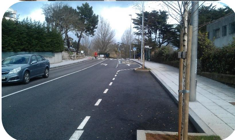
Figura 72. Arriba y abajo: tramo experimental de la mezcla AC16 S
