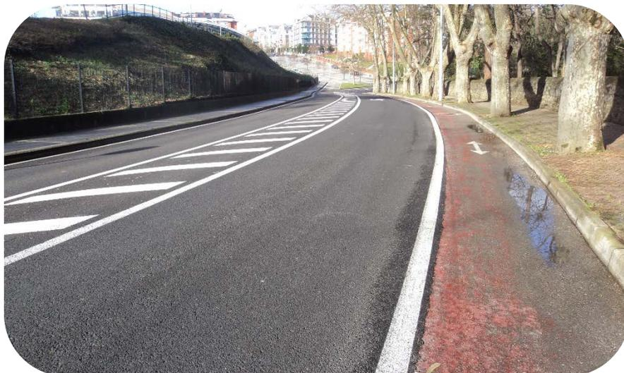
Figura 74. Tramo experimental de la mezcla BBTM 11 B
