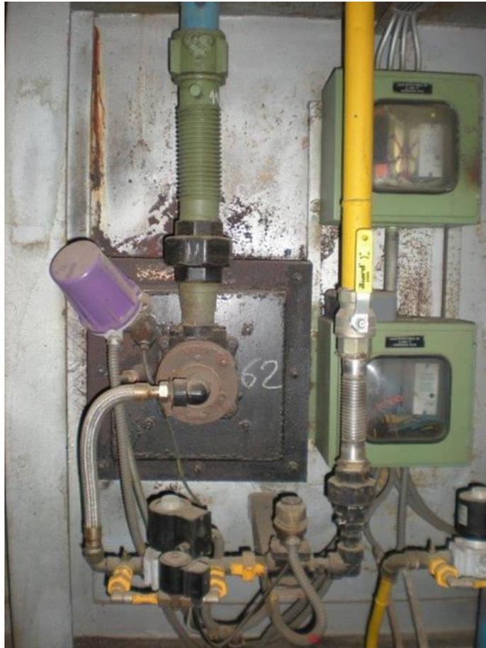
**Figura 59. Conjunto de quemador individual. Fuente: ENSA**
