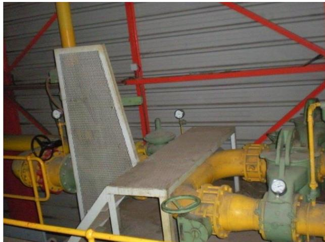
**Figura 74. Acometida de la entrada de gas. Fuente: ENSA**
