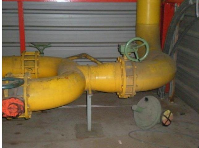
**Figura 73. Acometida de la entrada de gas. Fuente: ENSA**
