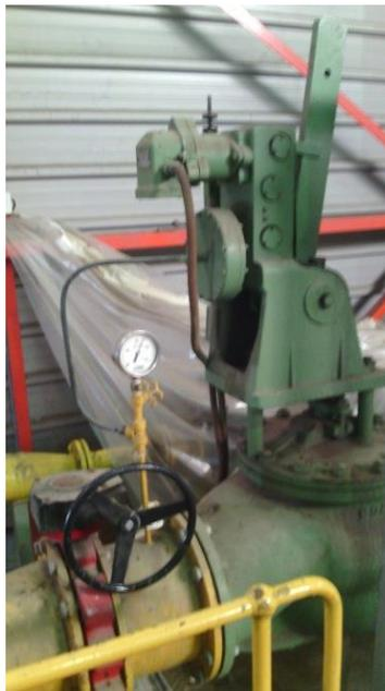
**Figura 75. Machete que permite la apertura de la conexión general del gas. Esta no se puede accionar si los ventiladores no están en marcha. Paso Nº10. Fuente: ENSA**
