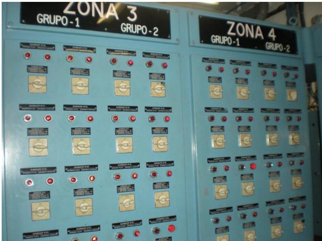
Figura 53. Conjunto de interruptores de los quemadores. Fuente: ENSA
