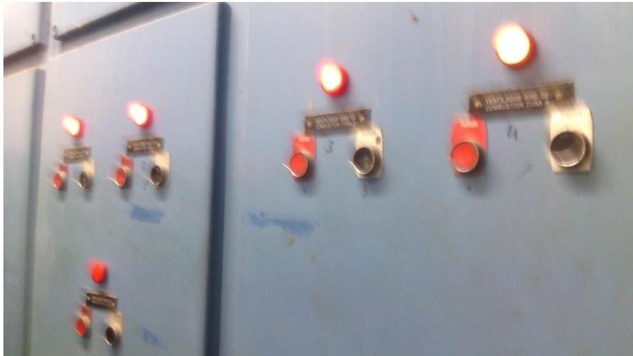
**Figura 72. Interruptores de los ventiladores. Fuente: ENSA**
