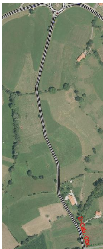
Figura 38: Detector en la carretera CA-408.
