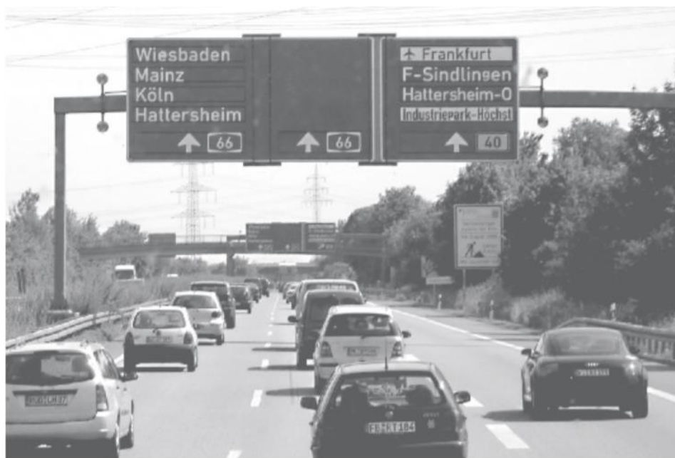
Figura 7: Panel VMS en Alemania con información de reenrutamiento. (Fuente: Active Traffic Management: The Next Step in Congestion Management).
