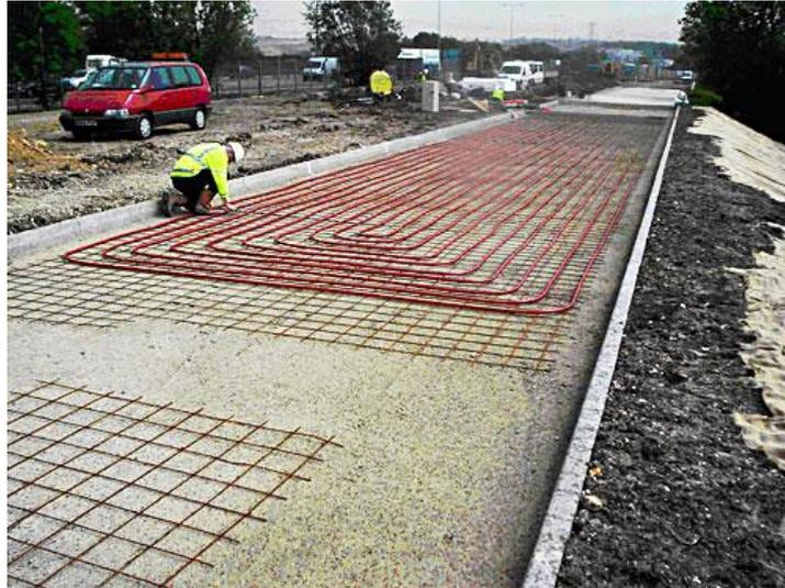
**Figura 9.** Instalación de colector solar en la autopista M1 de Toddington (*Fuente: ICAX.co.uk*)
