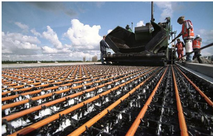
**Figura 8.** Instalación del sistema RES en una carretera en Holanda (Fuente: Ooms.nl)
