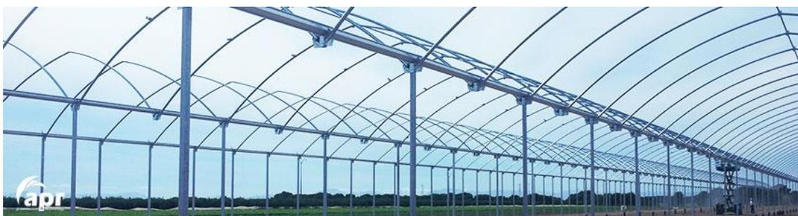
Figura 26. Fotografía de un invernadero gótico sin cobertura.
