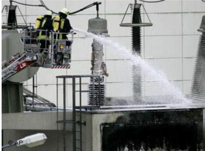
Figura 4.5. Avería de un transformador
