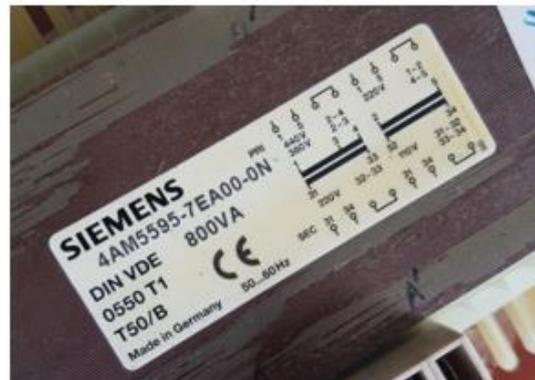
Figura 9.2. Vista del transformador -izq.- y placa de características -der.-
