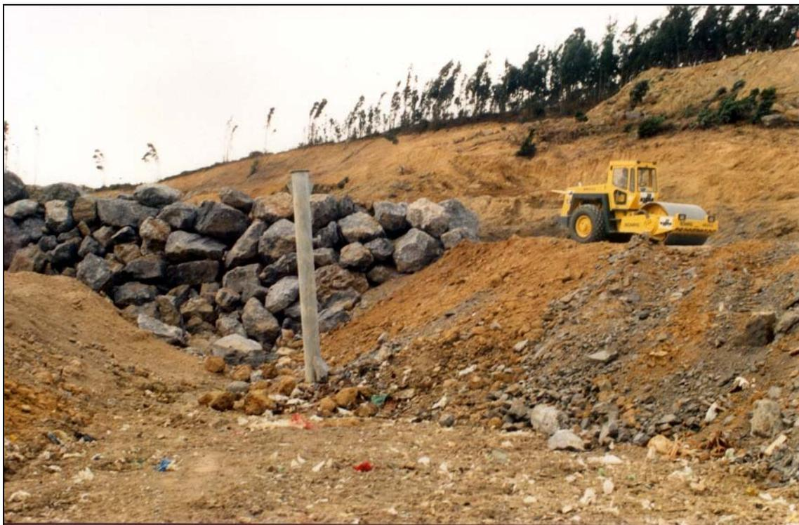
Fotografía II-3. Muro drenante central de escollera. Vista transversal.
