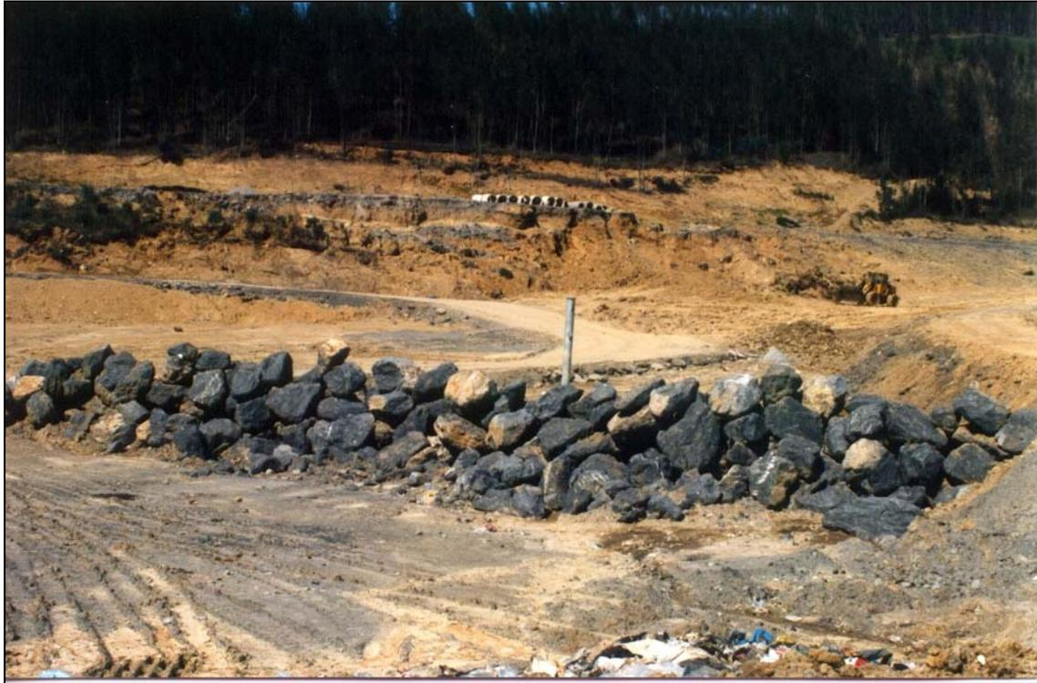
Fotografía II-2. Muro drenante central de escollera. Vista longitudinal.
