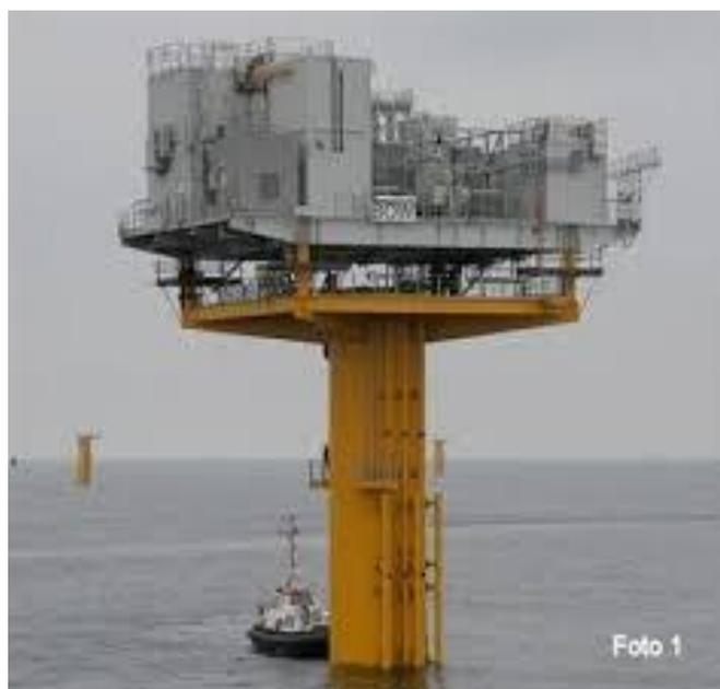
Figura 25 - Subestación transformadora offshore. Fuente: Renewables now
