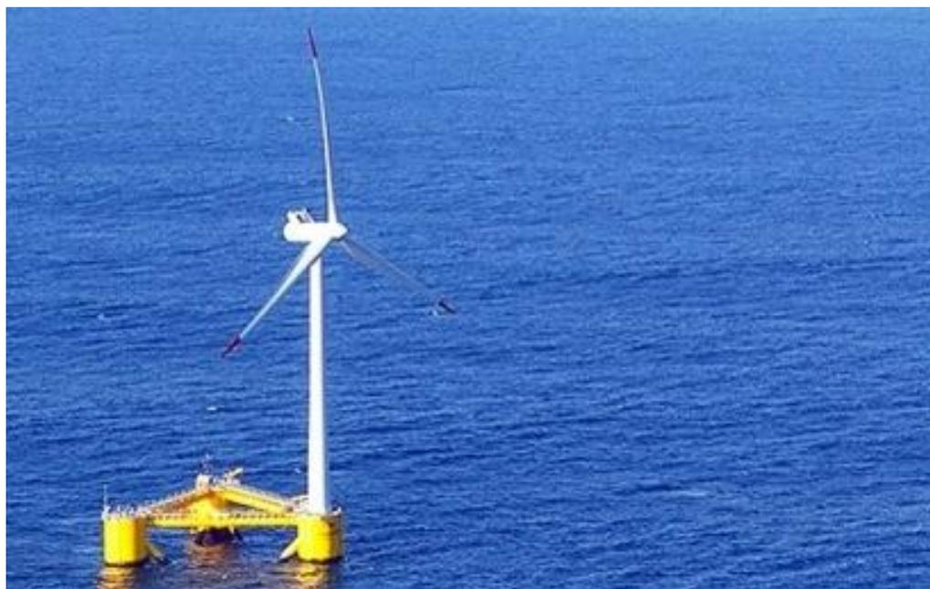
Figura 13 - Plataforma flotante WindFloat. Fuente: Principle Power
