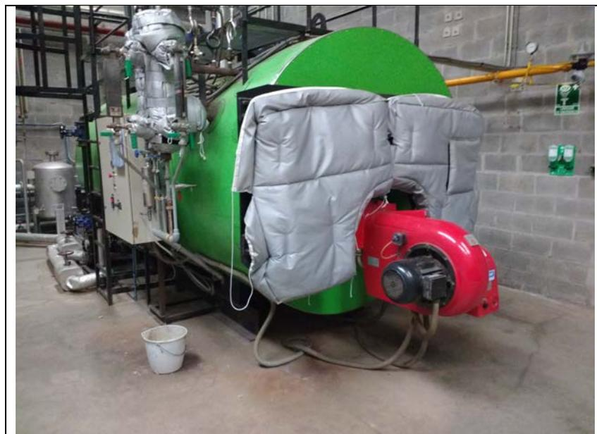
Figura 40. Caldera Ygnis generadora de vapor de producción. [Fuente: Fábrica T.]
