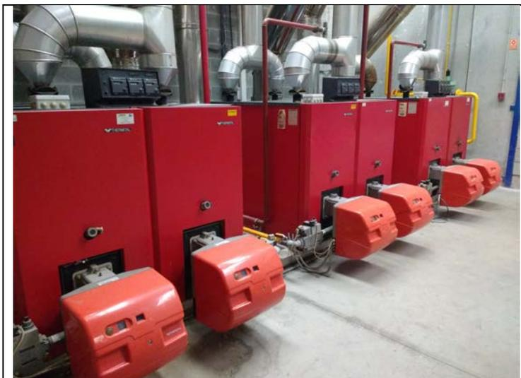
Figura 39. Calderas de climatización. [Fuente: Elaboración propia.]
