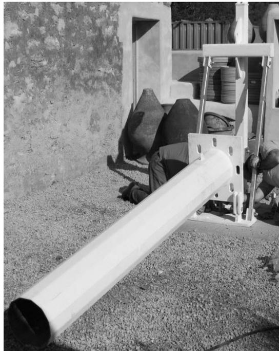
**5º PASO:** Una vez ensamblada la torre en el suelo, colocarla sobre un soporte que permita acoplar el aerogenerador.
