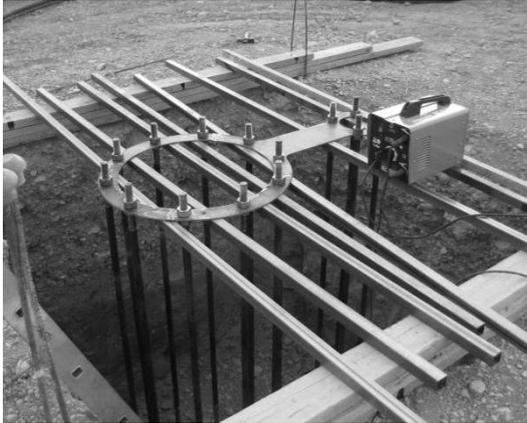
**2º PASO:** Asegurarse de que los tornillos salen de la superficie del hormigón, unos **20 cm**. Esto es muy importante para luego nivelar bien.
