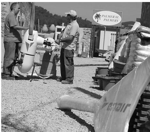
**8º PASO:** Una vez todo montado el aerogenerador elevarlo con el tráctel manual, sino se ha adquirido el sistema de elevación, utilizar grúa.
