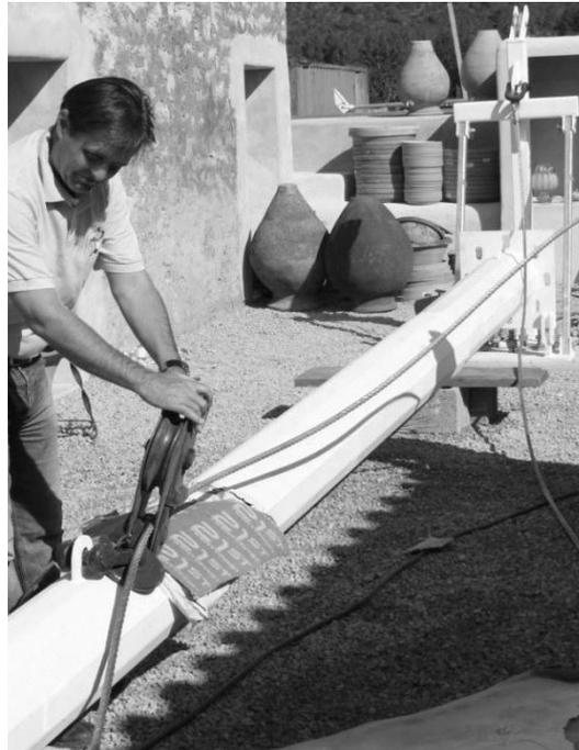
**7º PASO:** Montar el aerogenerador acoplándolo a los extremos de la torre, para montarlo completamente a ras del suelo (siempre con el molino en frenado).
