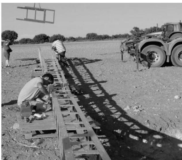
Ilustración 28, Montaje de la torre del aerogenerador. Fuente Manual de usuario aerogeneradores 30 y 70 Enair
