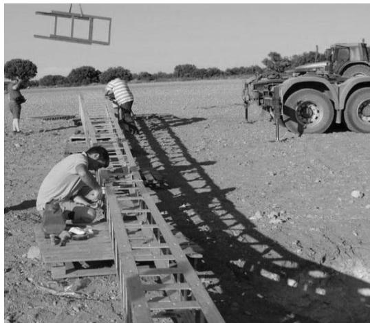
**2º PASO:** En posición horizontal, ensamblar la torre con el molino.
