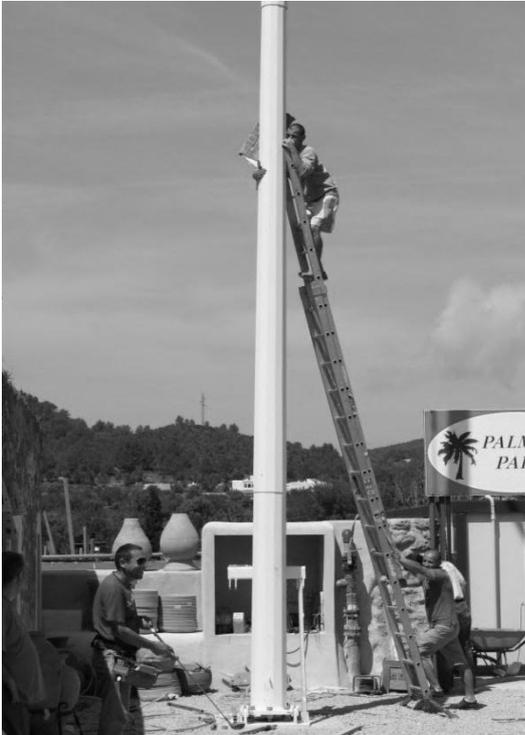
**10º PASO:** Una vez todo montado y acoplado perfectamente en posición, liberamos el freno del molino para que empiece a producir.
