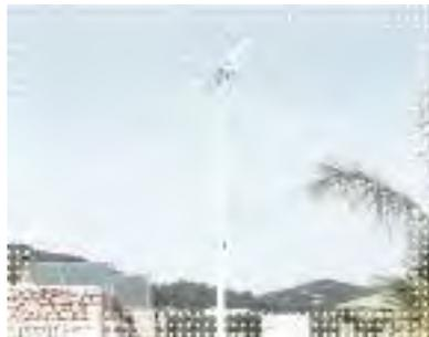
Con una velocidad de viento medio situado en la nominal de unos 10 - 12 m/s. El modelo **Enair 70** es capaz de generar hasta **70 kwh/día**.
