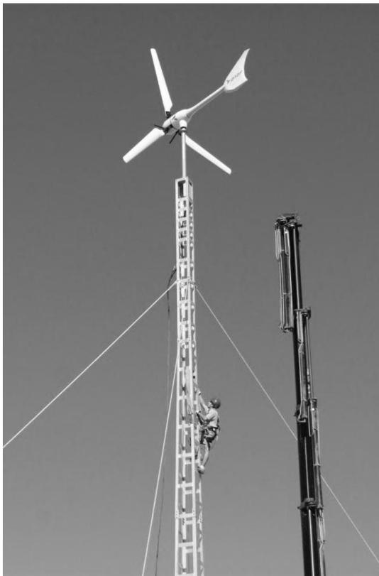
**6º PASO:** Transcurrido el periodo de tiempo necesario para el fraguado del hormigón, se quitan los tensores de la torre y se libera el aerogenerador, iniciando así la puesta en funcionamiento del mismo.
