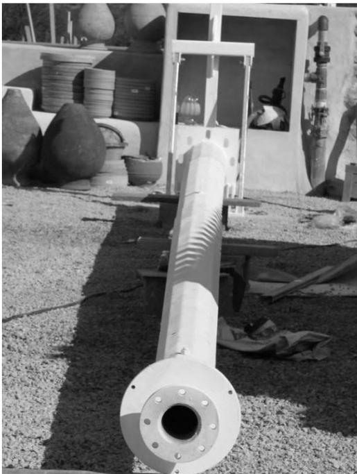
**4º PASO:** Colocar los tramos de la torre encastándolos uno dentro el otro. Y apoyándolo sobre el soporte (opcional) de elevación manual.
