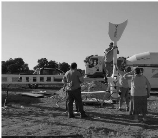
**3º PASO:** Enganchamos el Aerogenerador junto con la torre y elevamos el conjunto hasta el foso. Siempre con el molino frenado, por medio del cruce de sus fases.
