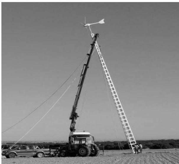
Ilustración 29, grúa levantando el aerogenerador. Fuente Manual de usuario aerogeneradores 30 y 70 Enair
