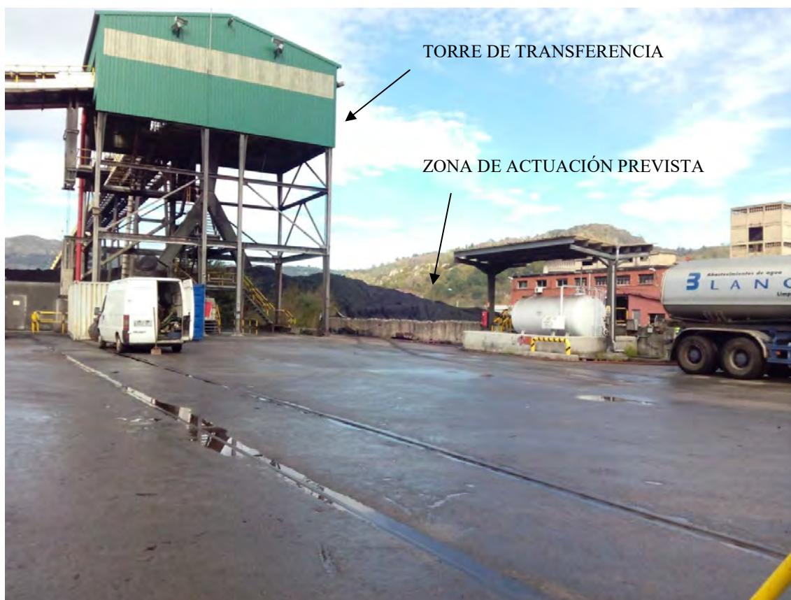
Zona de actuación prevista. Autor "Samuel Povedano García" Instalación de tolva y alimentador vibrante para el vertido y control del carbón sobre la cinta C4 antes del vertido de la cinta C5 sobre la C4
