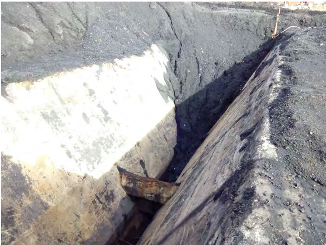
Canal de hormigón. Zona prevista de instalación de la tolva. Autor "Samuel Povedano García"
