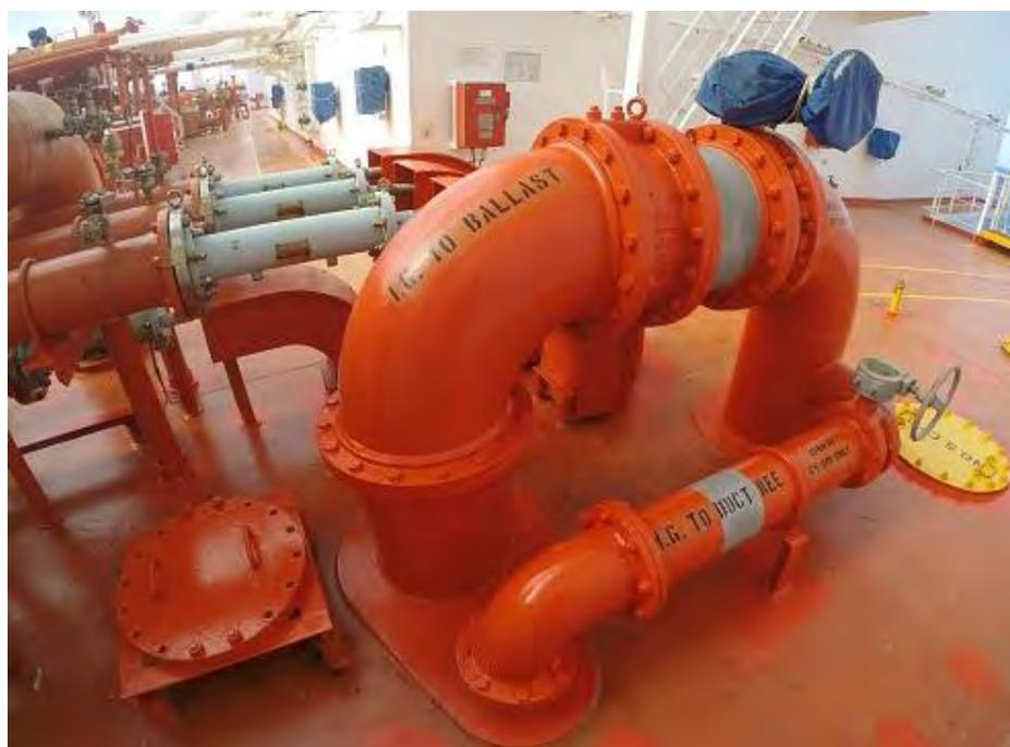
Ilustración 53 Línea de gas inerte que se introduce en los tanques de lastre y en el Duct Keel. Fuente: elaboración propia.
