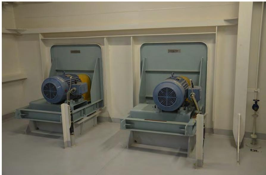
**Ilustración 95 Motores Eléctricos de las Bombas de Vacío. Fuente: elaboración propia**
