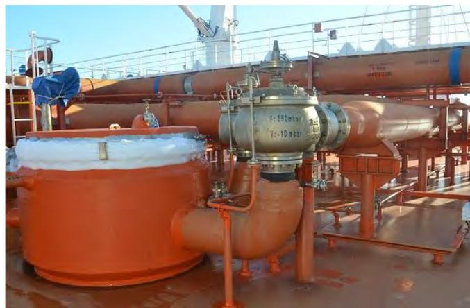
Ilustración 49 Válvula de seguridad que conecta el domo de Vapor con el palo de venteo. Fuente: elaboración propia
