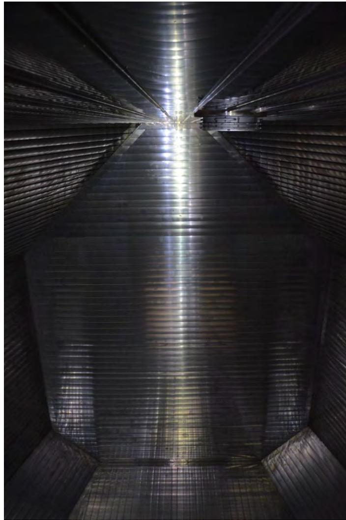
Ilustración 23 Interior de un tanque de Membrana con sistema N0.96 a la vista el Domo de Vapor.
