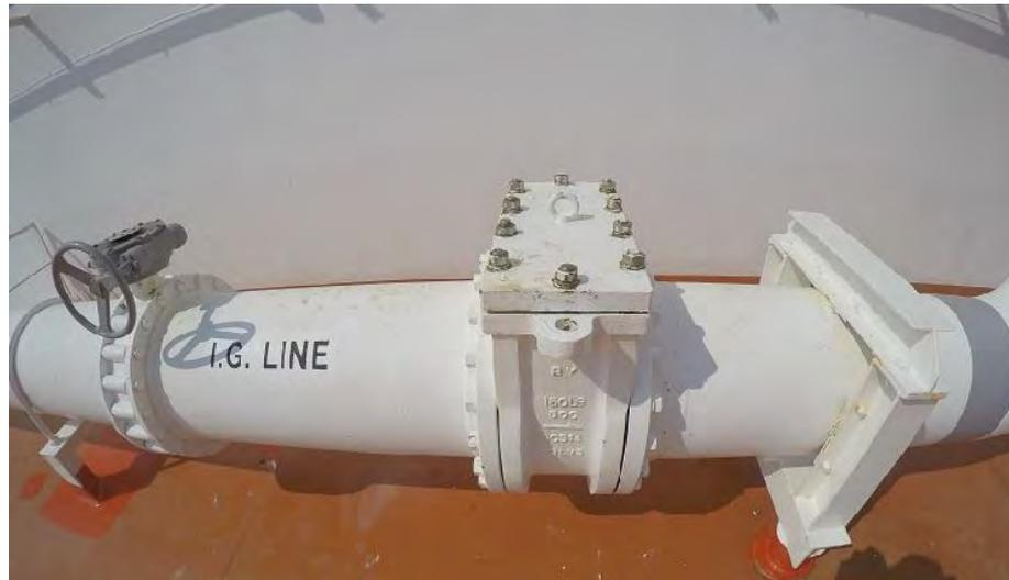
Ilustración 52 Línea de gas inerte. Fuente: elaboración propia
