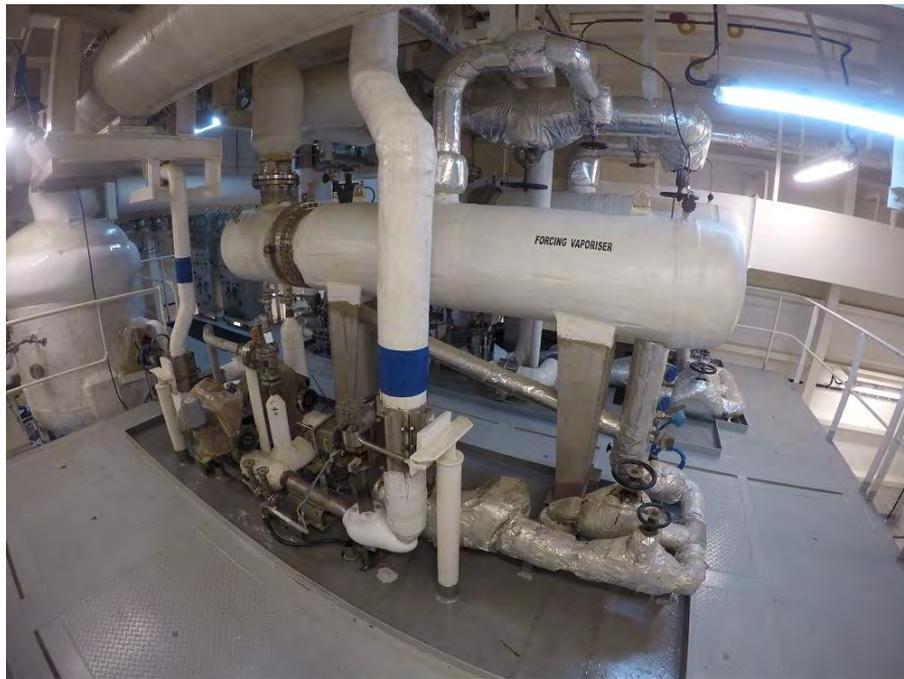
**Ilustración 92 Forcing Vaporiser. Fuente: elaboración propia**
