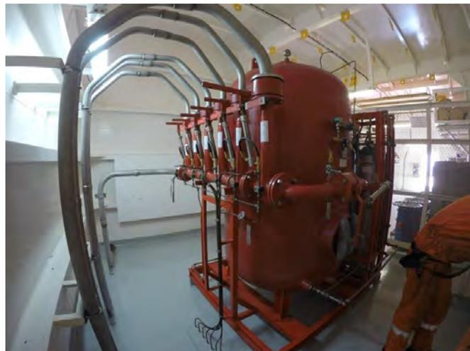
Ilustración 118 Detalle estación polvo seco. Fuente: elaboración propia
