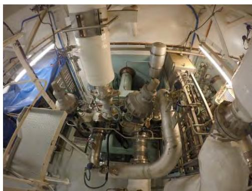
**Ilustración 85 Compresore Low Duty. Fuente: elaboración propia**
