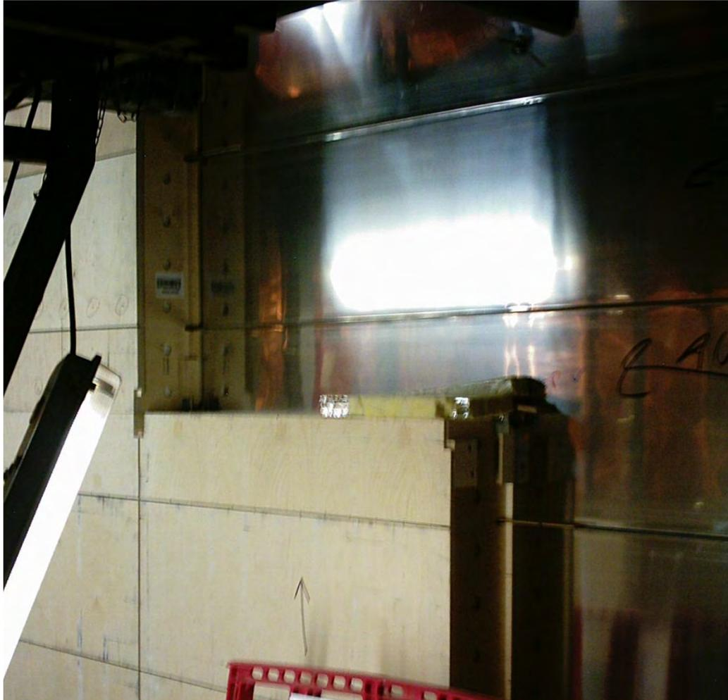
Ilustración 17 Cajas de la barrera primaria unidas a las planchas de la barrera secundaria.
