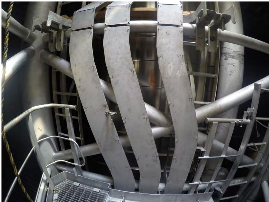
**Ilustración 102** Detalle de por dónde bajan hasta el final del tanque de carga los sensores de temperatura. Fuente: elaboración propia
