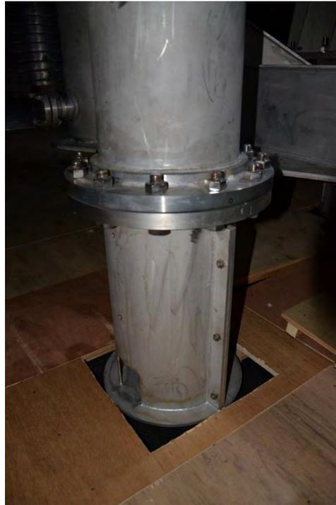
**Ilustración 101** Tubería por donde baja el flotador. Fuente: elaboración propia
