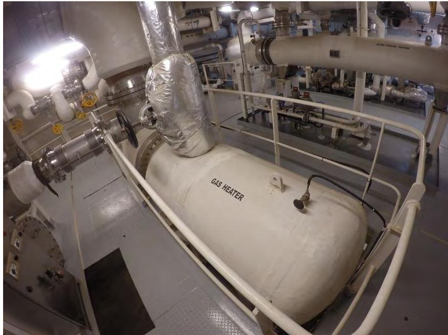
Ilustración 86 Gas Heater en el Cuarto de Compresores. Fuente: elaboración propia
