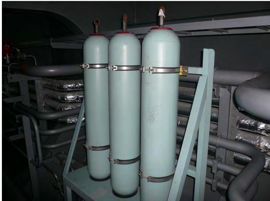
**Ilustración 122** Detalle de botellas llenas de aceite hidráulico en los Passageways. Fuente: elaboración propia
