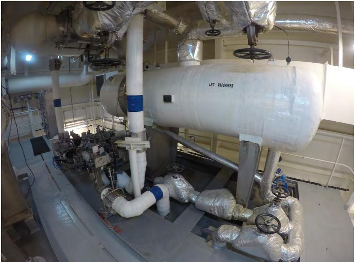
**Ilustración 90 LNG Vaporiser. Fuente: elaboración propia.**
