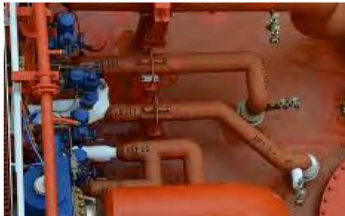
Ilustración 46 Línea de Spray introduciéndose en un tanque por el domo de Líquido. Fuente: elaboración propia.
