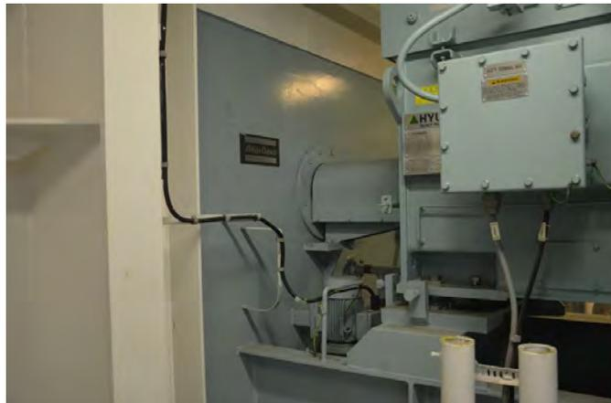
**Ilustración 79** Mamparo y sello de nitrógeno en cuarto de motores eléctricos. Fuente: elaboración propia.
