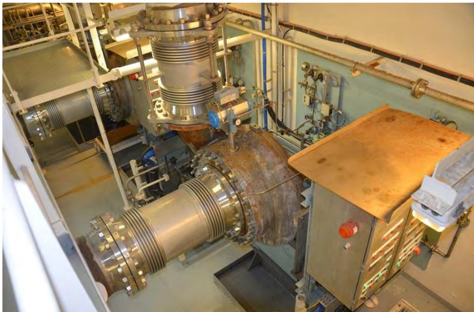
Ilustración 82 Compresor High Duty. Fuente: elaboración propia
