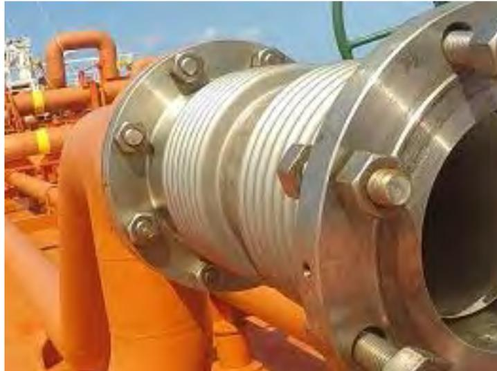
**Ilustración 42** Detalle de los anillos de expansión de línea de nitrógeno. Fuente: elaboración propia
