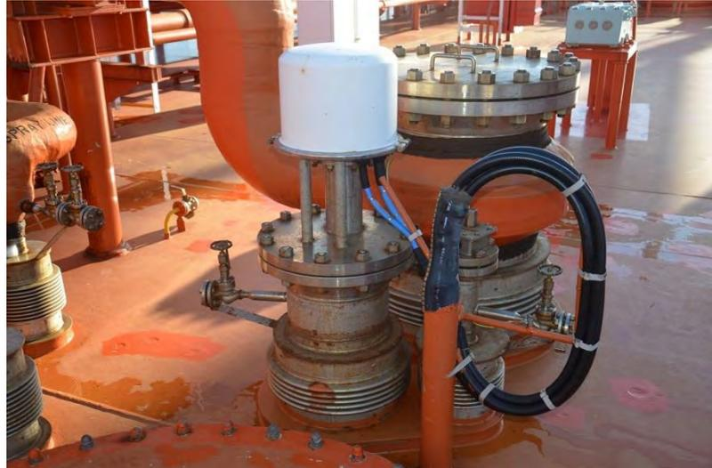
**Ilustración 97** Caja electrónica que procesa la señal del radar. Fuente: elaboración propia
