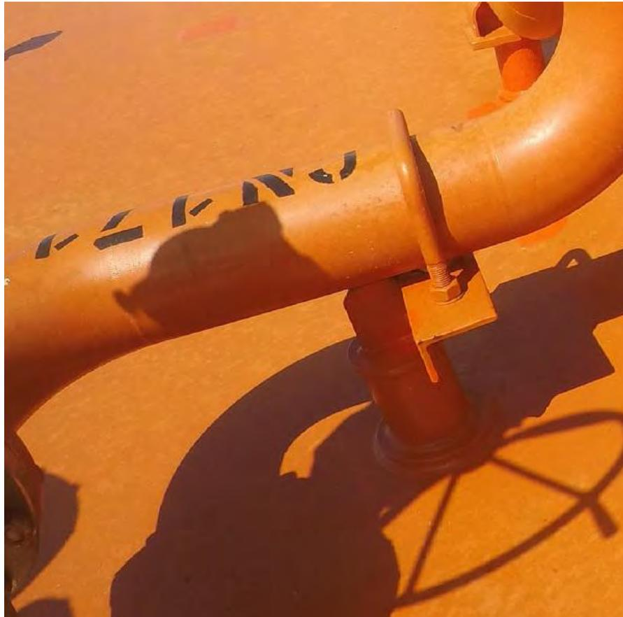
**Ilustración 41** Detalle de fijación de una línea a la cubierta. Donde apoya se encuentra el teflón.
