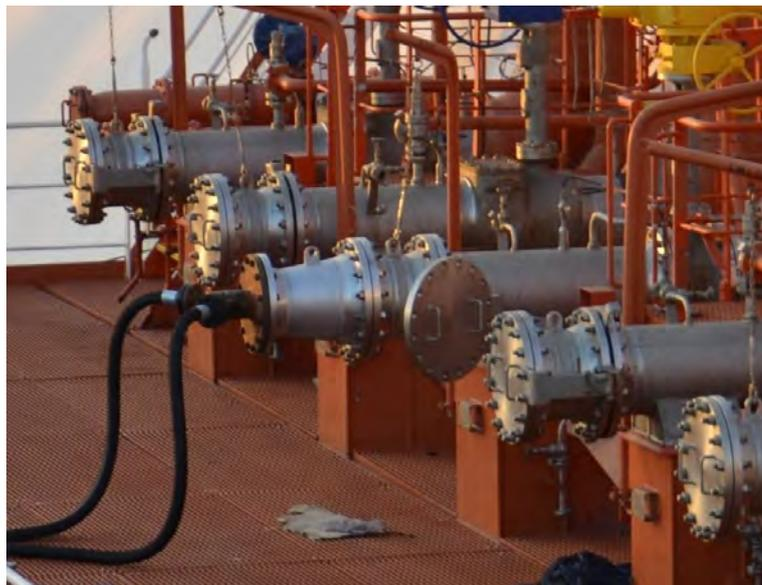
Ilustración 129 Líneas de nitrógeno conectadas al brazo de Vapor en astillero. Fuente: elaboración propia
