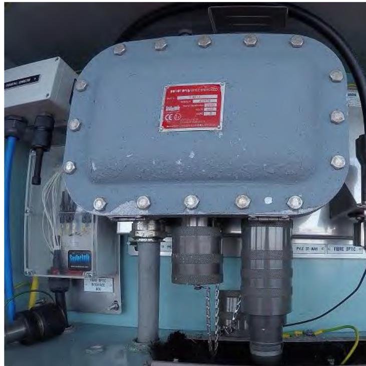
Ilustración 110 Conexión Pyle National 37-way Fuente: elaboración propia
