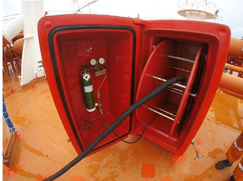
Ilustración 117 Detalle Hose Cabinet de polvo seco. Fuente: elaboración propia
