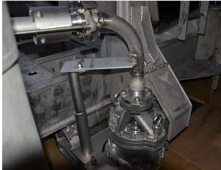
**Ilustración 69** Bomba de Stripping en el interior de un tanque. Fuente: elaboración propia
