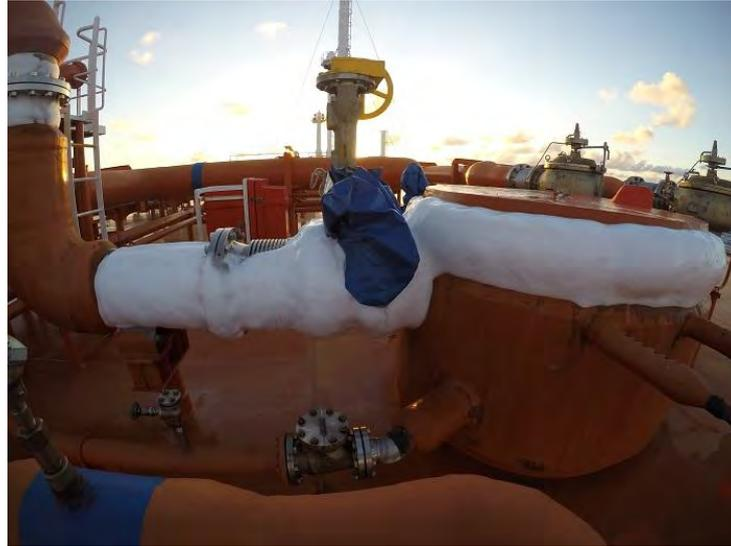
Ilustración 48 Línea de Vapor conectada a un Domo de Vapor. Fuente: elaboración propia
