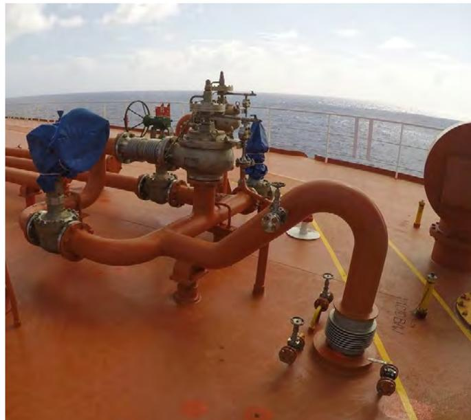
Ilustración 114 Válvula de seguridad de la barrera primaria y entrada de N2 en la misma barrera. Fuente: elaboración propia
