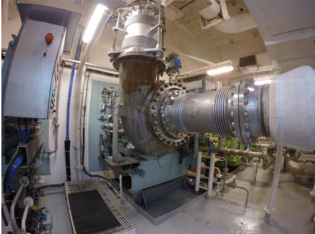
Ilustración 83 Compresor High Duty. Fuente: elaboración propia
