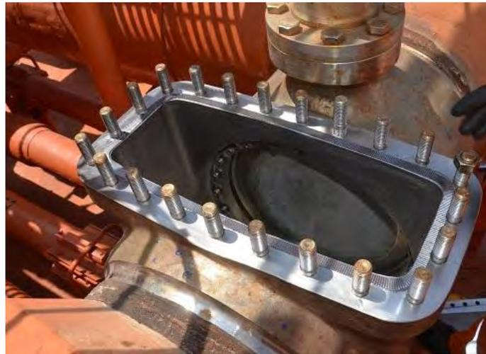
Ilustración 55 Válvula en una línea de líquido en la Trunk Deck. Fuente: elaboración propia.
