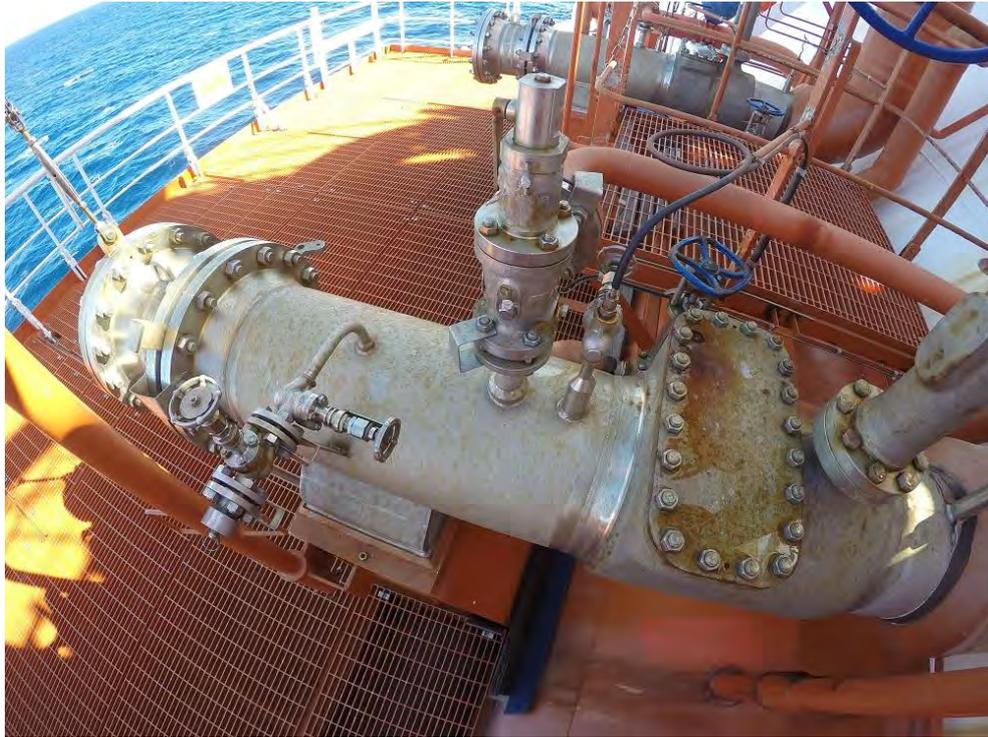
Ilustración 115 Válvula de seguridad en un brazo de líquido del Manifold. Fuente: elaboración propia
