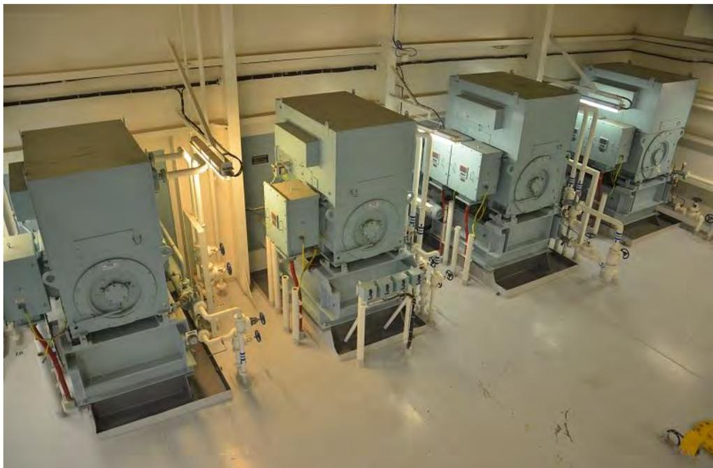
**Ilustración 78 Motores eléctricos que accionan a los compresores. Fuente: elaboración propia**
