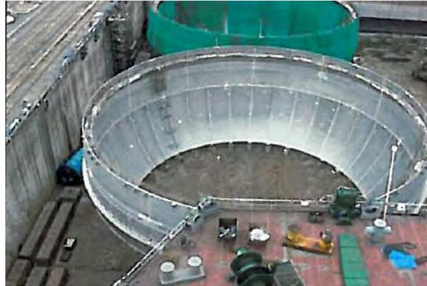
Ilustración 9 Camisas centrales de los tanques esféricos. Fuente: SIGTTO
