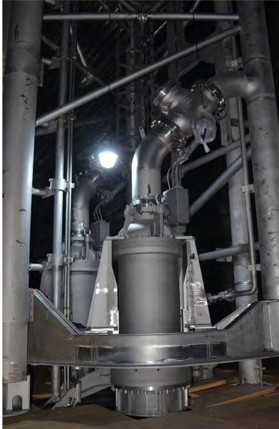
**Ilustración 64 Bomba descarga dentro de un tanque. Fuente: elaboración propia**
