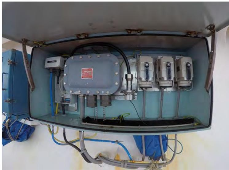
Ilustración 133 Caja de conexión debajo del Manifold. Fuente: elaboración propia
