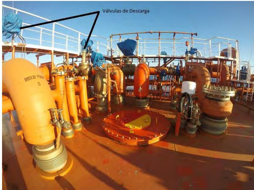
Ilustración 67 Válvulas de descarga. Fuente: elaboración propia
