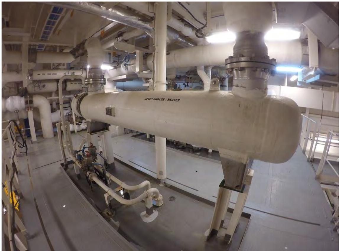
**Ilustración 88 After Cooler/Heater. Fuente: elaboración propia**
