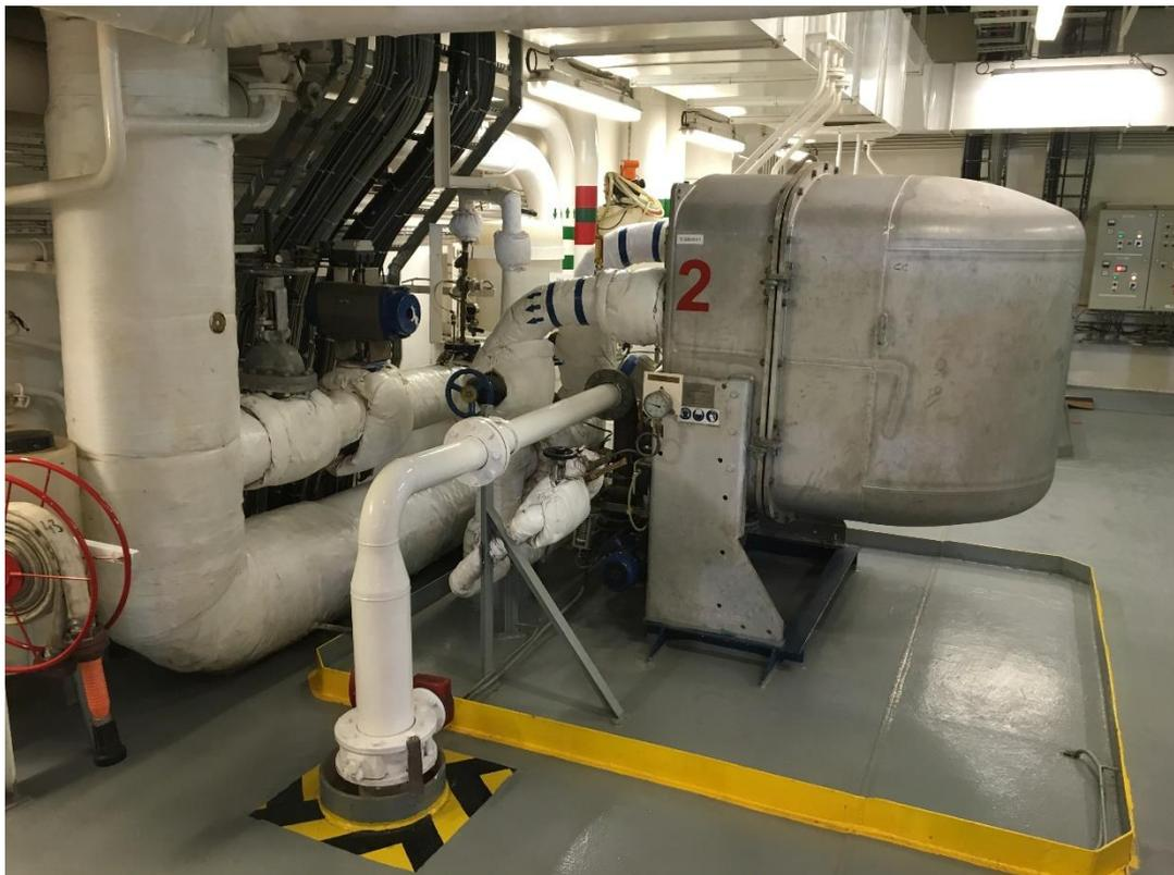
*Figura 28. Generador de agua destilada con condensación por agua de condensado.*
