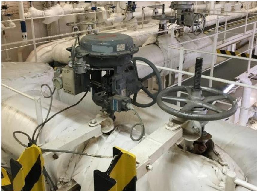
*Figura 19. Válvula reguladora de descarga o dumping. Fuente: (Propia).*
