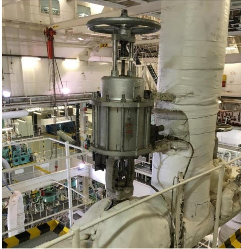
*Figura 18. Válvula automática de pistón. Fuente: (Propia).*
