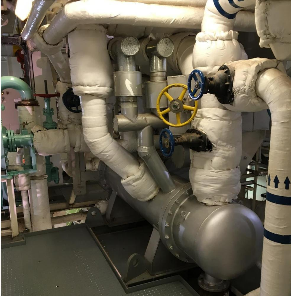
*Figura 29. "Gland condenser" o condensador de vahos. Fuente: (Propia).*
