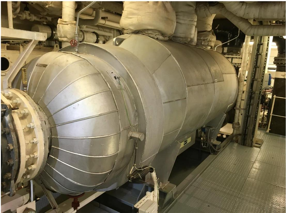
*Figura 27. Condensador atmosférico. Fuente: (Propia).*
