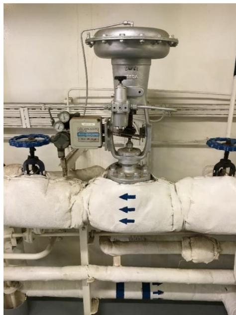
*Figura 33. Válvula make up con válvulas de incomunicación correspondientes.*
