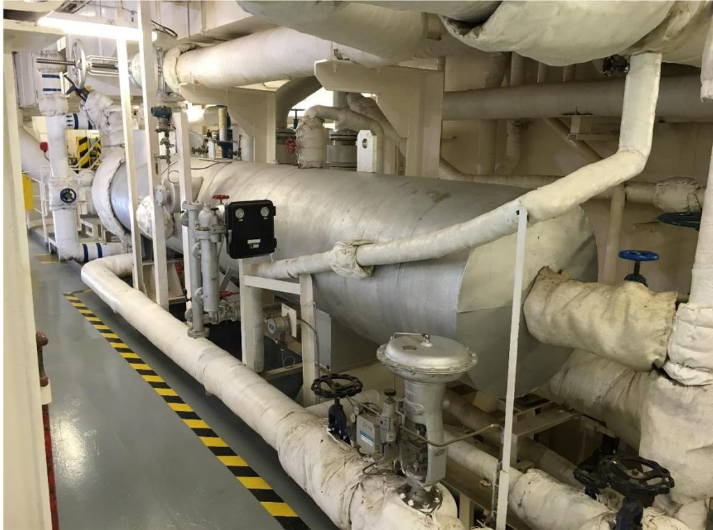
*Figura 30. "L.P. Heater" o calentador de baja presión. Fuente: (Propia).*
