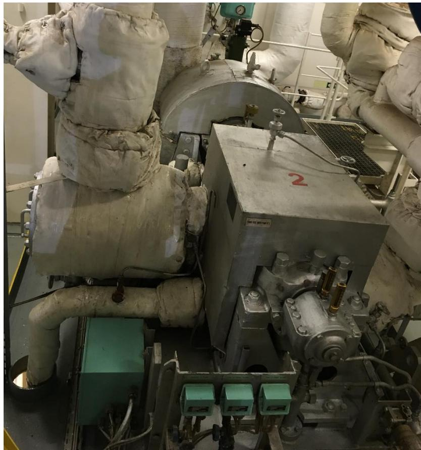
*Figura 17. Turbobombas de alimentación de las calderas. Fuente: (Propia).*
