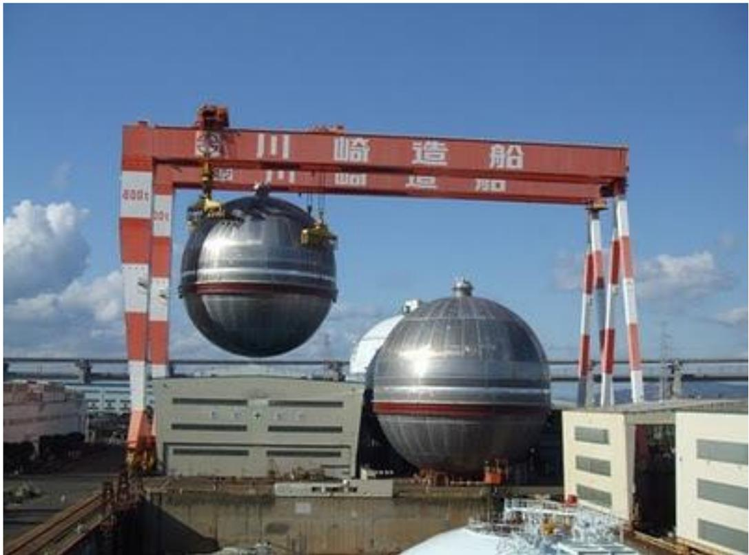
*Figura 7. Tanque independiente tipo B o tipo Kvaerner-Moss.*
