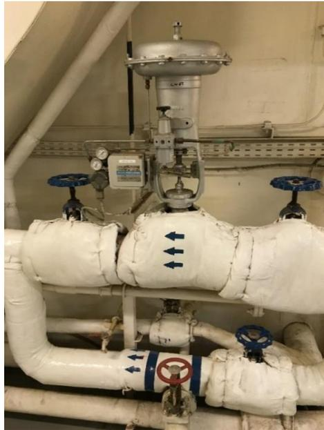
*Figura 32. Válvula spill con su by-pass correspondiente y sus válvulas de incomunicación. Fuente: (Propia).*
