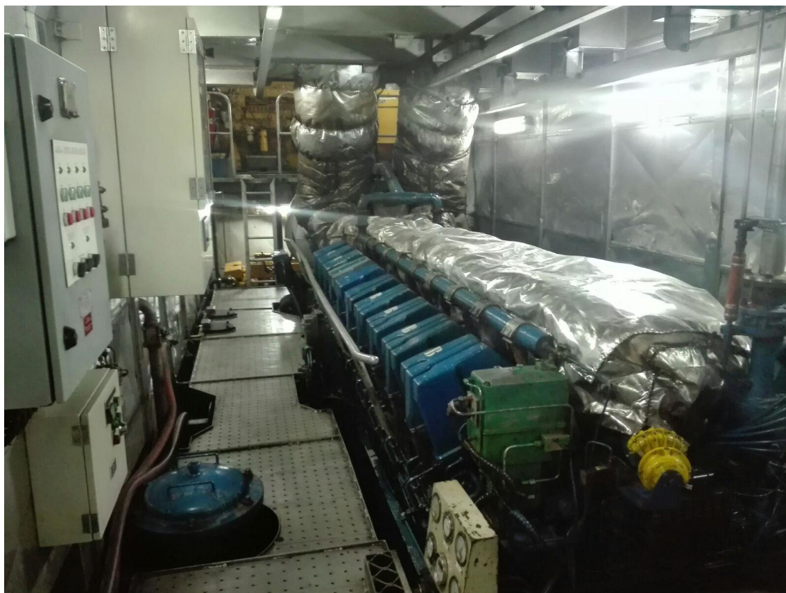
Figura 9: Vista de una de la sala de máquinas del buque “MILENIUM II”.
