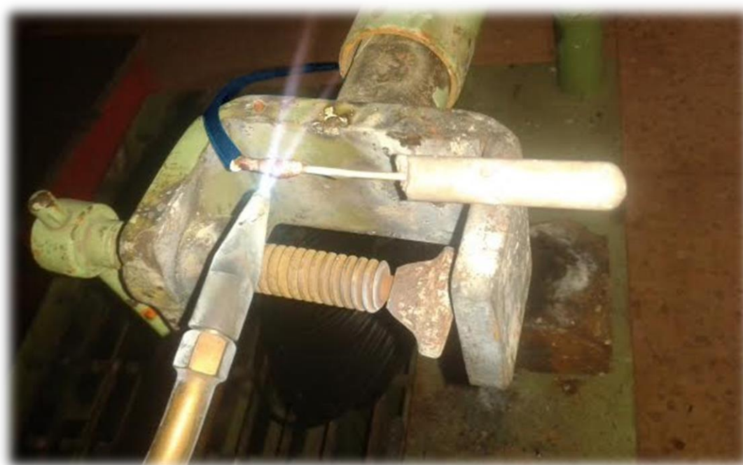
Figura 34: Soldadura del electrodo de referencia al conductor
