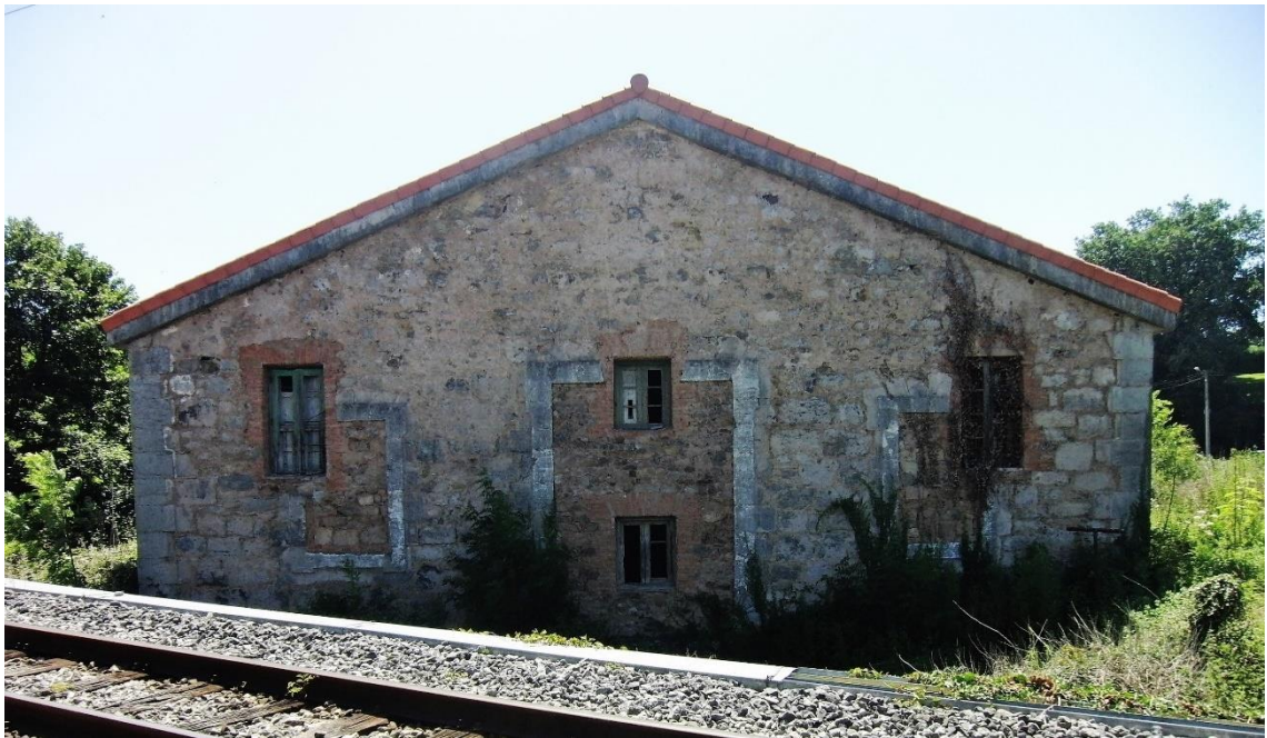
-Ilustración 4-9. Vista lateral del almacén. Se aprecia cómo han tapiado las ventanas originales y han abierto otras nuevas que corresponden a la creación de una segunda planta. -Fuente: fondo propio.
