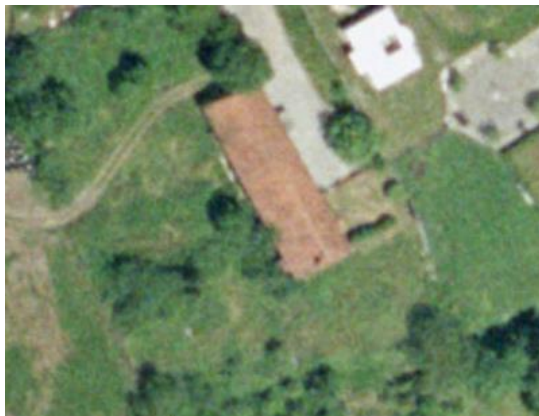
-Ilustración 4-5. Foto aérea del edificio en 2005. -Fuente: http://mapas.cantabria.es/ (visto 13/07/2017)
