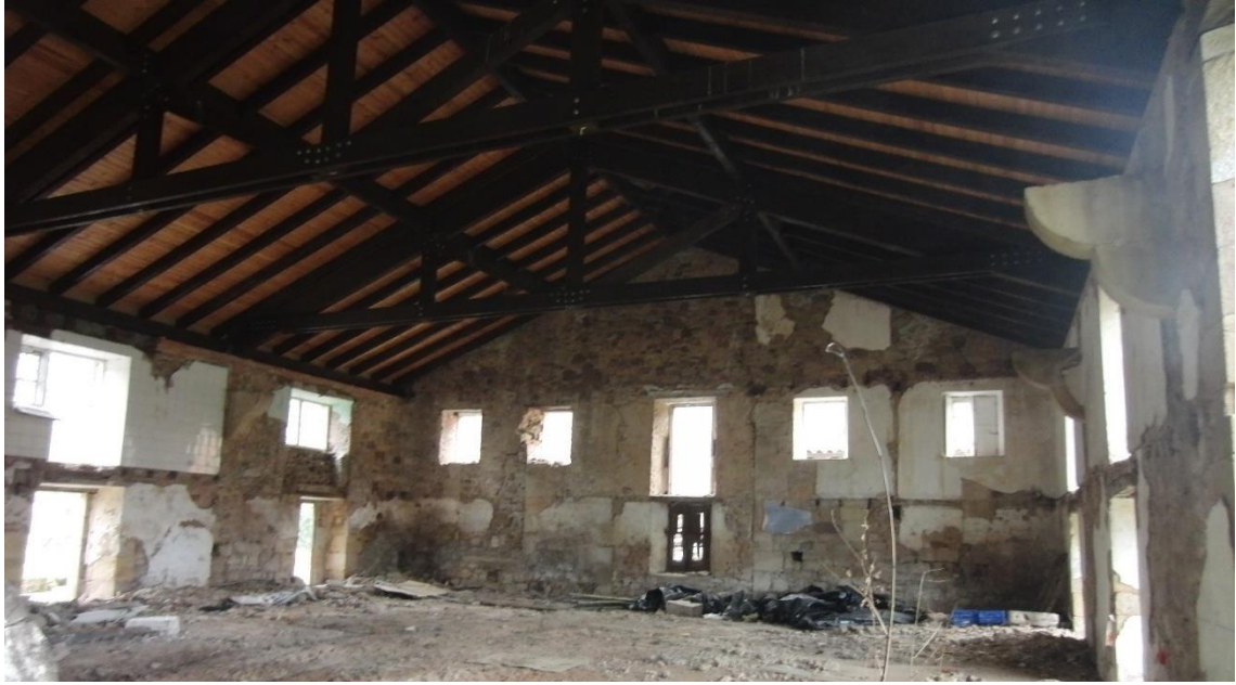
-Ilustración 4-10. Interior del almacén/ taller. Se puede observar el techo nuevo, el suelo cubierto de tierra y las paredes desenfoscadas. Estructuralmente está bien, por lo que las intervenciones se limitarían es estas cuestiones estéticas. -Fuente: fondo propio.
