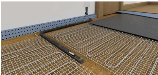
23. "Serpentín de tuberías de un suelo radiante" Fuente: leroymerlin.es
