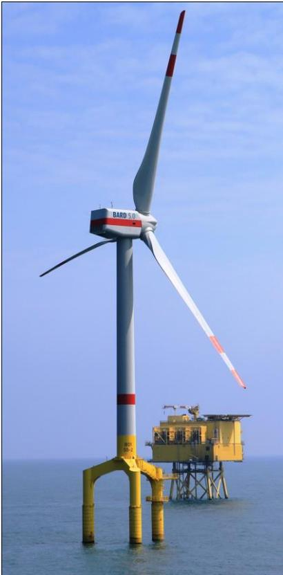
ILUSTRACIÓN 3.20. TURBINA CON BASE TRIPILE DEL PARQUE BARD OFFSHORE 1 [18]
