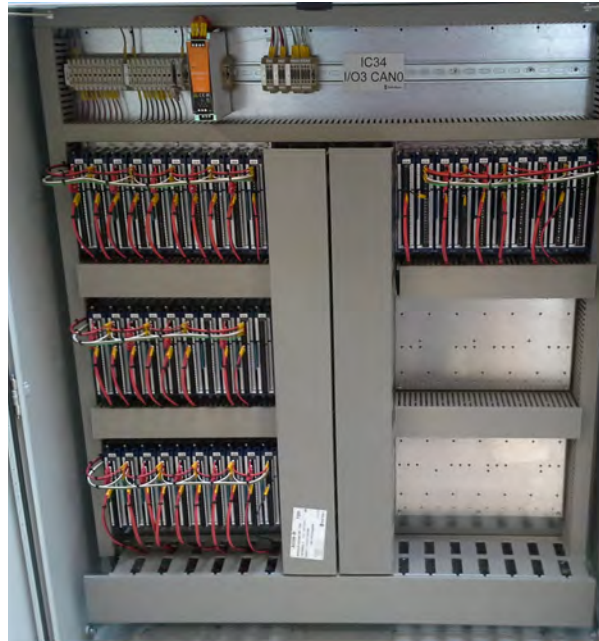
Ilustración 7.9 – Cabina de módulos E/S IC34 del buque Stril Luna (Rolls-Royce ACON-R)
