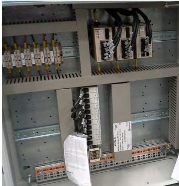
Ilustración 7.12 – Cabina de Redes NC12 del buque Stril Luna (Rolls-Royce ACON-R)
