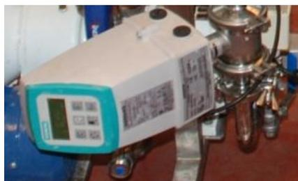
Figura 2.20. Indicador de caudal de la fase alimentación IRC-1.
