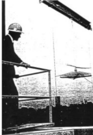
*Figura 2.4 Demostración de transferencia de potencia por microondas (MPT) a un helicóptero por W. C. Brown. [4]*
