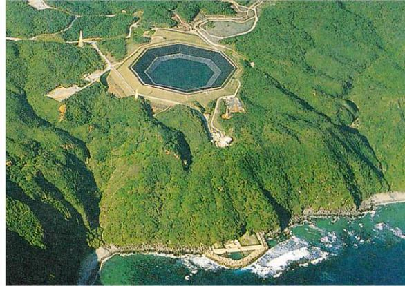
Figura 8. Central de bombeo de agua de mar Okinawa Yanbaru. T. Fujihara et al. 1998.
