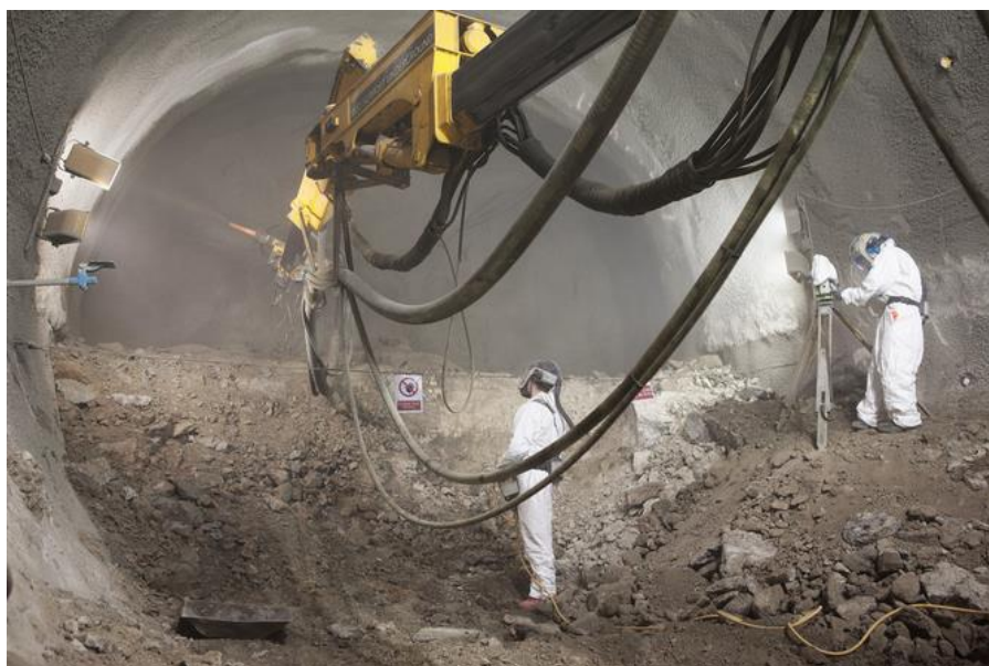
Ilustración 16. Construcción estaciones subterráneas. Fuente: Crossrail. http://www.crossrail.co.uk/
