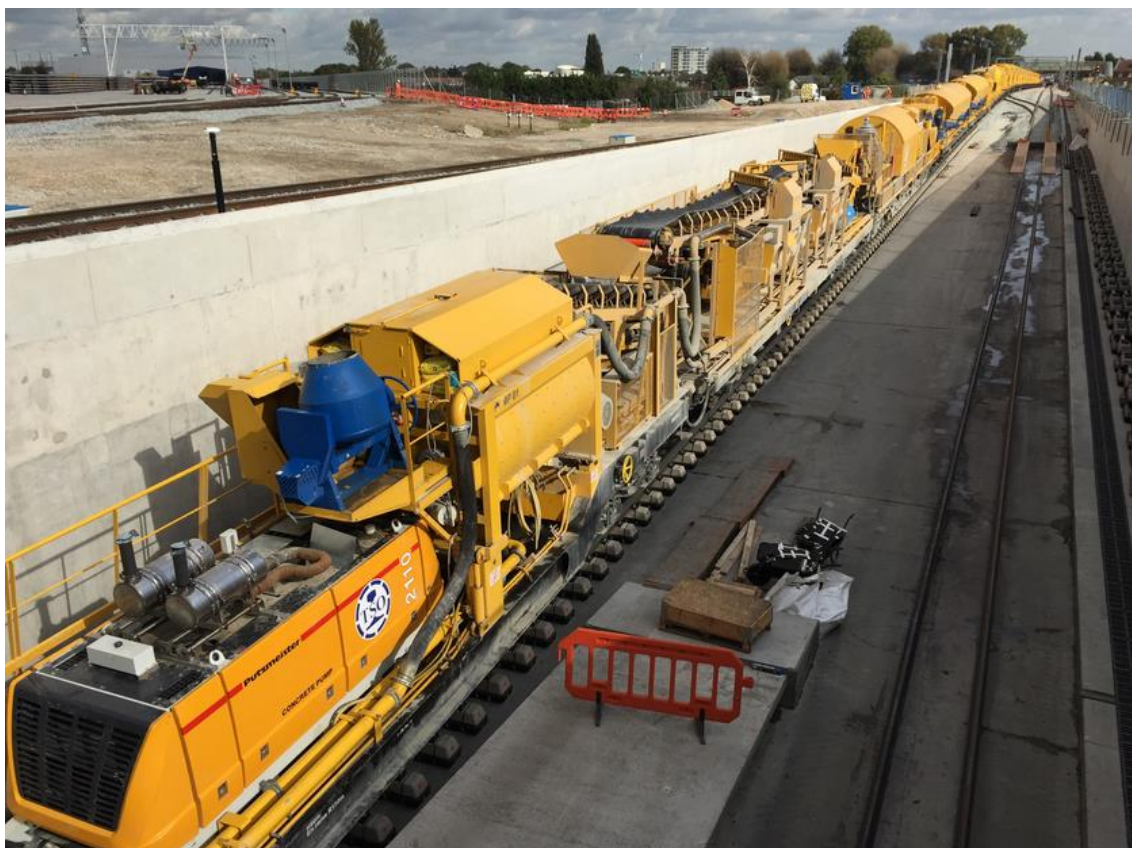
Ilustración 18. Tren de hormigonado. Fuente: Crossrail. http://www.crossrail.co.uk/
