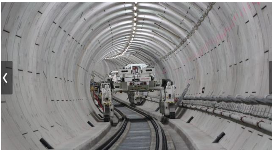
Ilustración 19. Pórticos para la construcción. Fuente: Crossrail. http://www.crossrail.co.uk/
