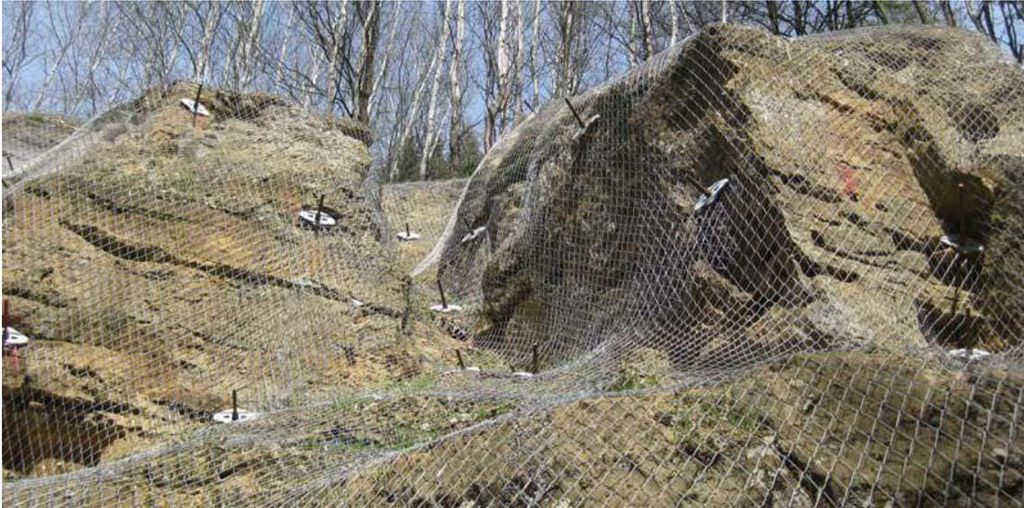
*Foto de una malla de alambre con anclajes.*
