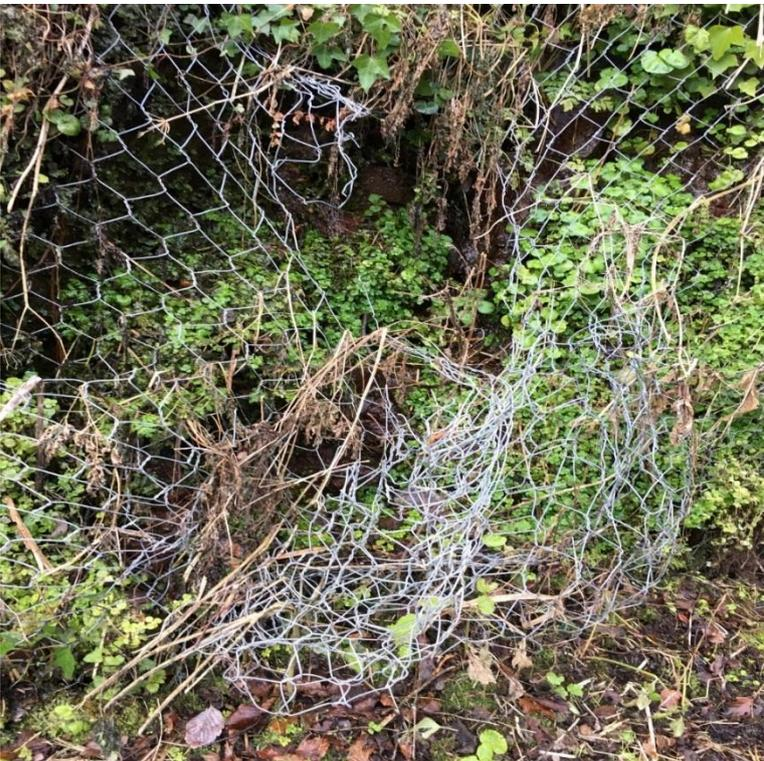
*Fotografía de una malla de alambre en malas condiciones el tramo 5 en la N-611 (Cantabria).*
