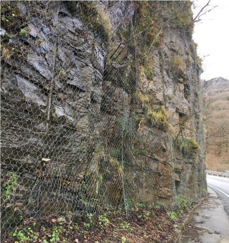
*Fotografía de una malla de alambre en el tramo 5 en la N-611 (Cantabria).*
