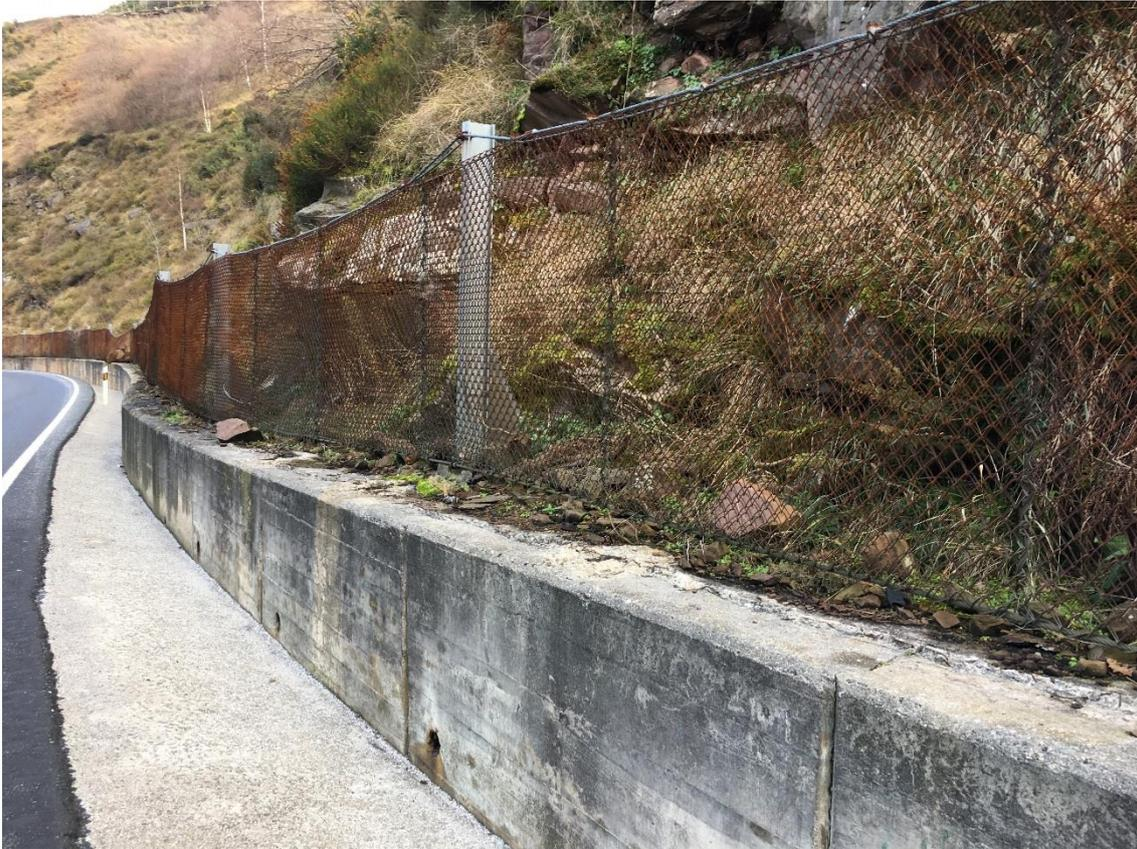
*Fotografía del tramo protegido mediante pantallas dinámicas en la N-611 (Cantabria).*
