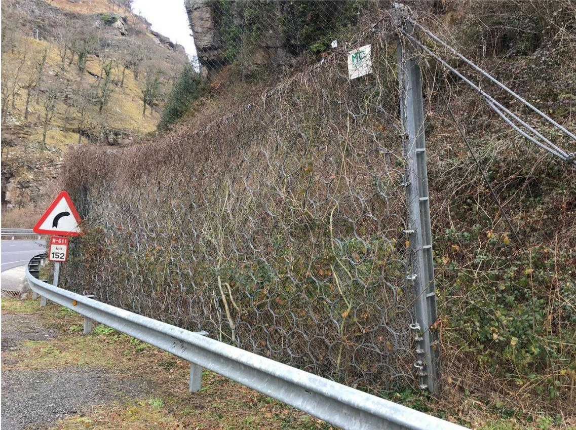
*Fotografía de una pantalla dinámica en el tramo 4 en la N-611 (Cantabria).*
