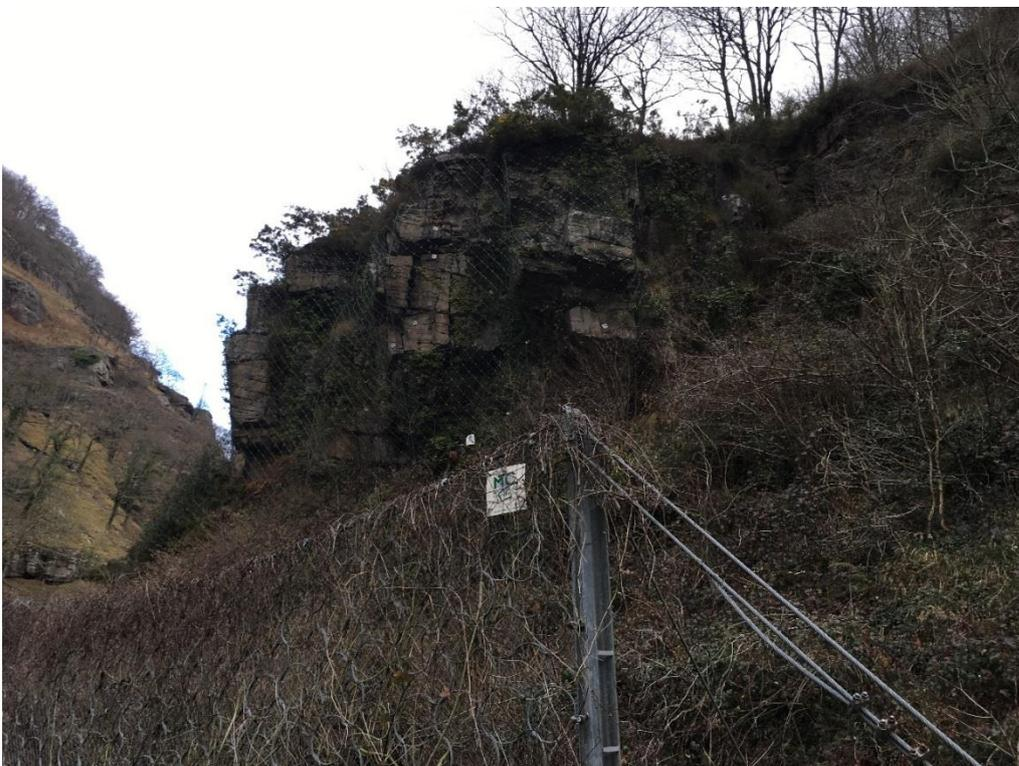
*Fotografía de una red de cable en el tramo 4 en la N-611 (Cantabria).*
