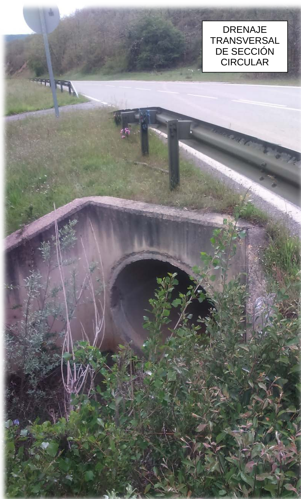
Figura 85. Dos de los drenajes transversales que cruzan la carretera CA-272 en Valderredible (Fuente: elaboración propia).
