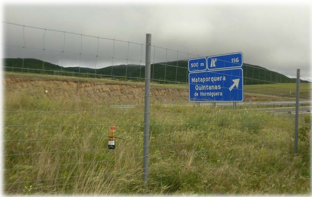
Figura 20. Botella de 33 cl con repelentes olfativos colocada en el vallado perimetral de la autovía de la Meseta A-67, a la altura de Mataporquera, Cantabria. (Fuente: elaboración propia).
