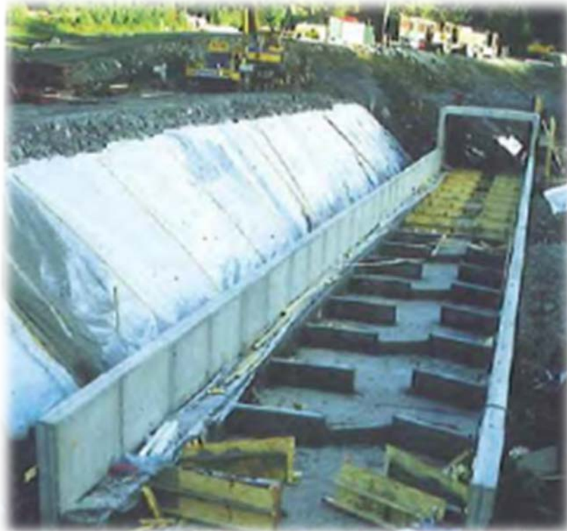
Figura 51. Chapas divisorias de un drenaje en construcción en Noruega. (Foto de B. Iuell).
