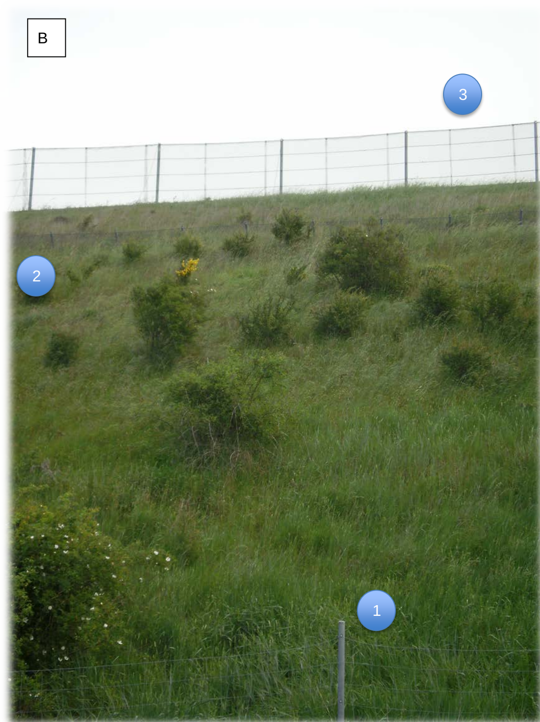
Figura 92. Vallado perimetral de la Autovía A-67 a su paso por Valdeprado del Río (Fuente: elaboración propia).
