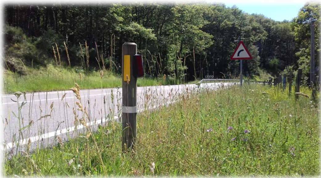
Figura 22. Catadióptrico colocado en poste de madera en la carretera local CA-730 de Cantabria (Fuente: elaboración propia).
