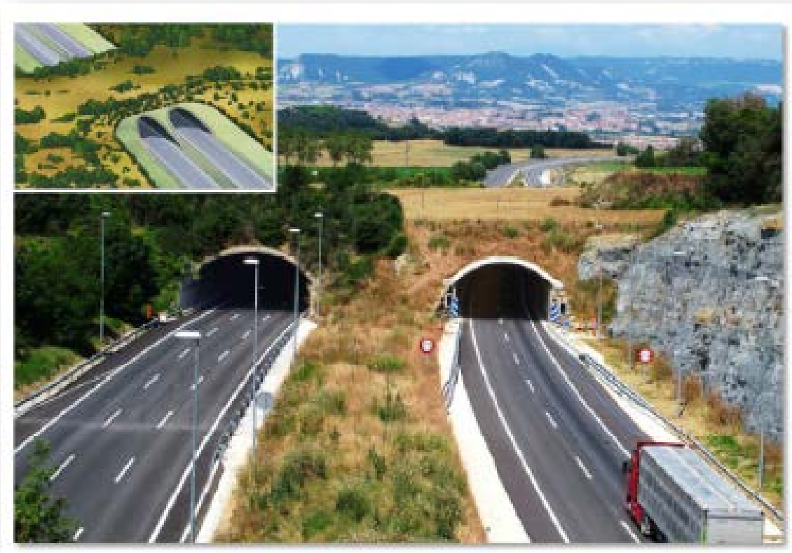
Figura 37. Vista general del ecoducto del Túnel de Sant Julià 1, en la C-25 Cataluña. (Fuente: Documento Inventari d'estructures de connectivitat a la xarxa viària catalana ).
