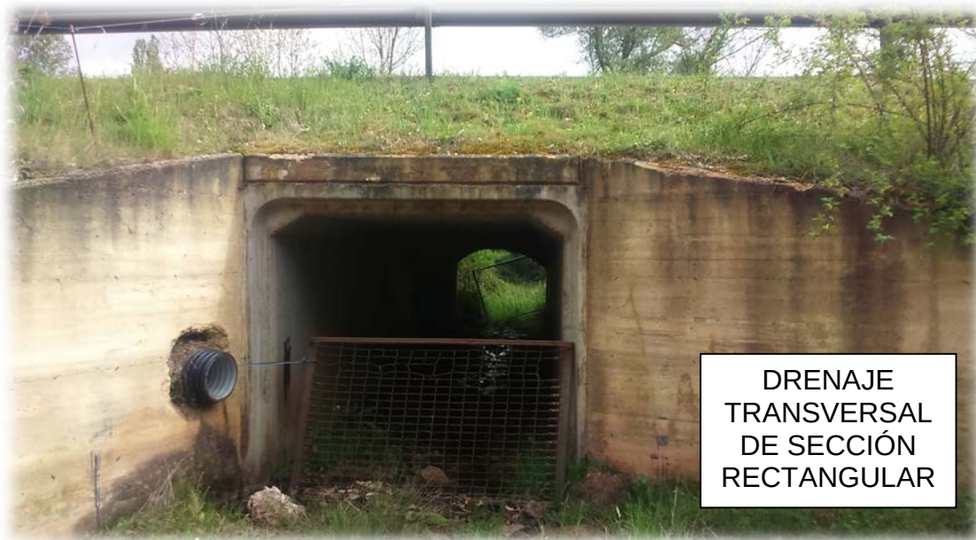
Figura 84. Vista de un drenaje rectangular de la carretera CA-272 en Valderredible (Fuente: elaboración propia).
