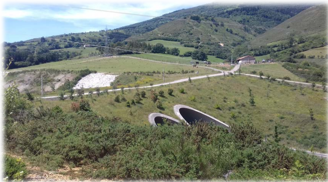
Figura 39. Paso superior de fauna multifuncional en la autovía de la Meseta A-67, Mollo, Cantabria. (Fuente: elaboración propia).
