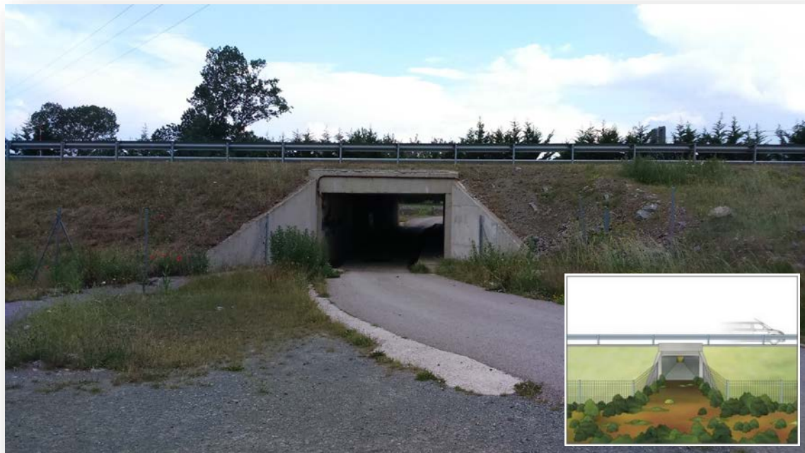
Figura 12. Vallado perimetral con terminación en un paso inferior de la autovía de la meseta A-67 a la altura de Bolmir, Cantabria (Fuente: elaboración propia).
