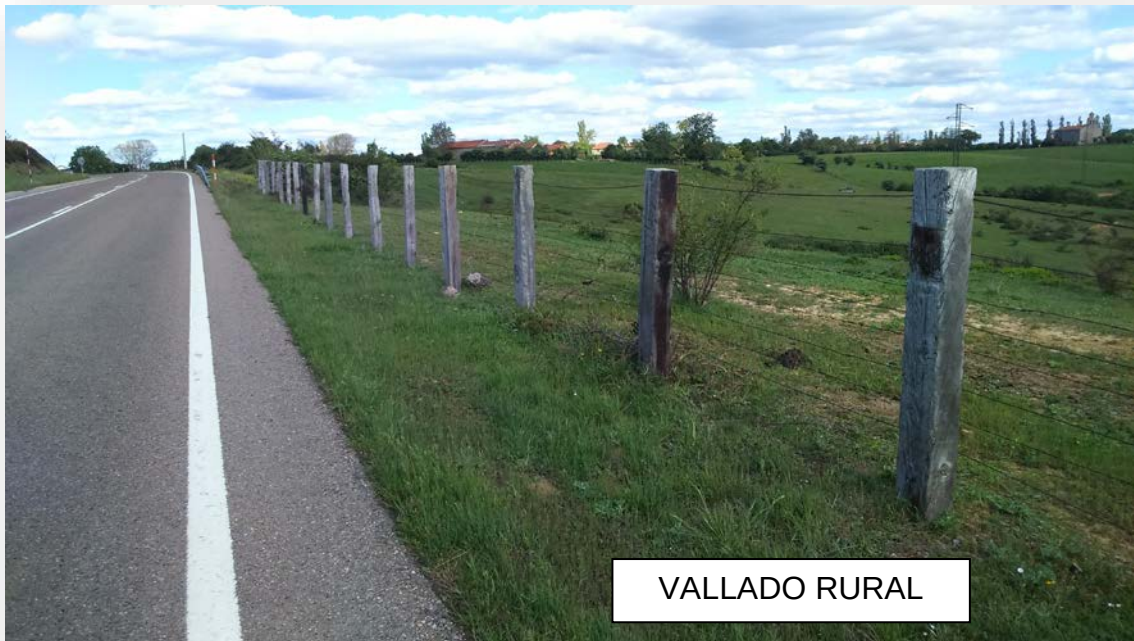
Figura 72. Vallado rural en la carretera CA-171 (Fuente: elaboración propia).
