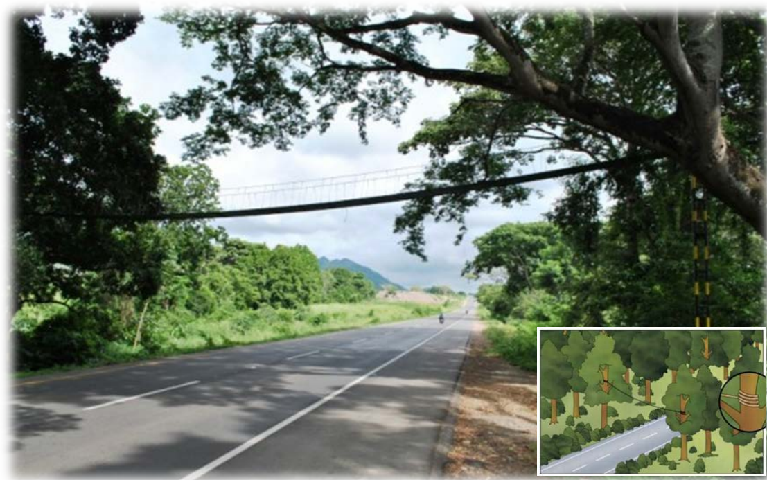
Figura 40. Paso superior entre árboles en Colombia. (Fuente: http://rutadelsol.com.co/responsabilidad-ambiental-en-la-ruta-del-sol-sector-2-2/ ).
