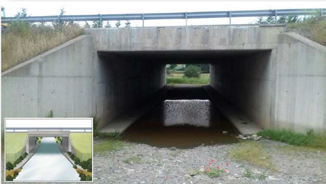
Figura 48. Vista de un drenaje adaptado con banquetas laterales de la autovía A-67, Cantabria (Fuente: elaboración propia).
