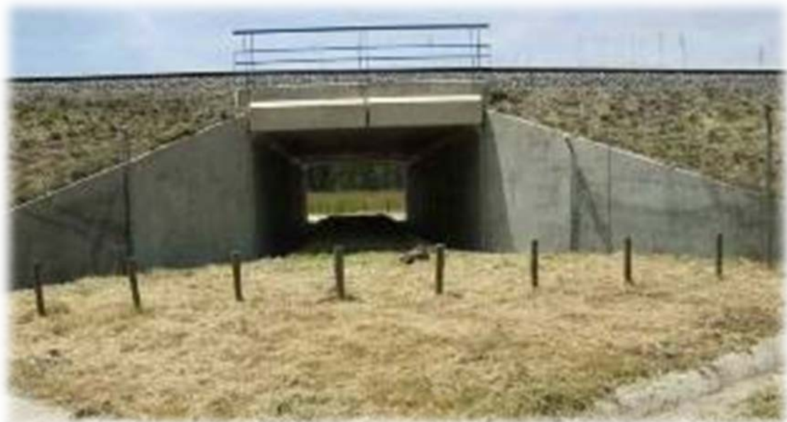
Figura 43. Paso inferior específico para la fauna con vegetación y elementos que impiden el paso de vehículos. (Fuente: Llorente & Díez, 2008).
