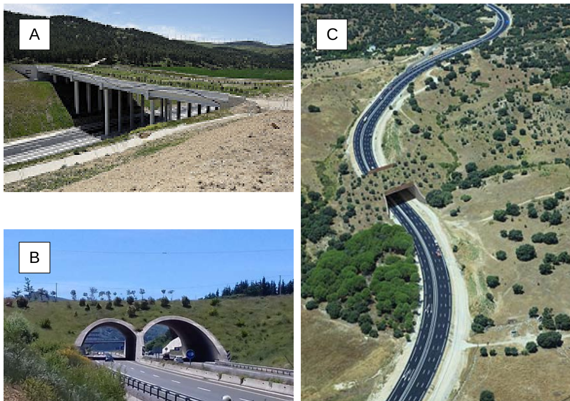
Figura 32. Diferentes tipologías constructivas de pasos superiores de fauna. A. Tablero, Navarra. (Fuente: http://ehizabai.blogspot.com.es/2010/05/autovia-tambien-para-los-jabalies.html ). B. Bóveda, paso superior multifuncional de Molledo, Cantabria (Fuente: elaboración propia). C. Falso túnel, Madrid. (Fuente: http://www.elmundo.es/elmundo/2008/08/01/madrid/1217605454.html ).
