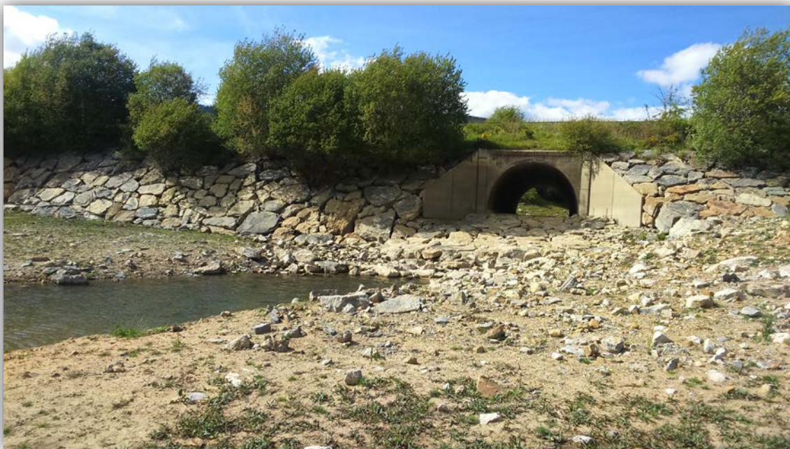
PASO INFERIOR DE AGUA
