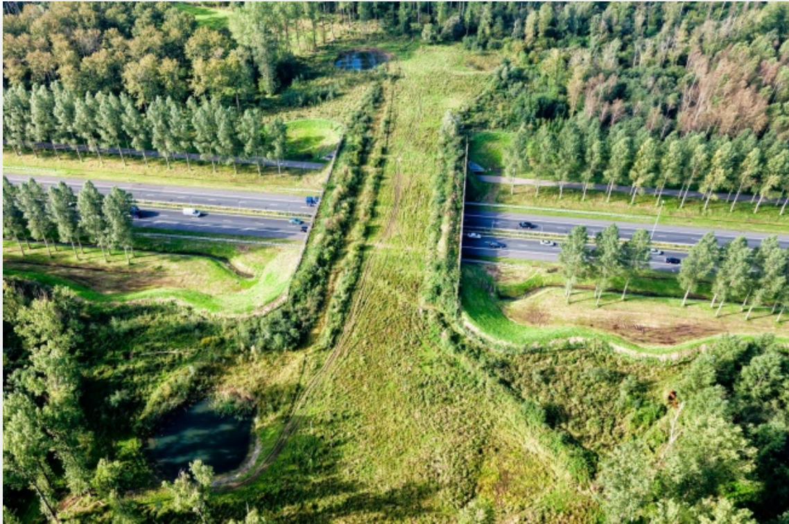
Figura 30. Disposición de arbustos en hilera que facilitan la conducción de la fauna hacia un paso superior en Holanda. )Fuente: https://genial.guru/admiracion-lugares/7-pruebas-de-que-holanda-es-el-pais-del-futuro-265710/ .
