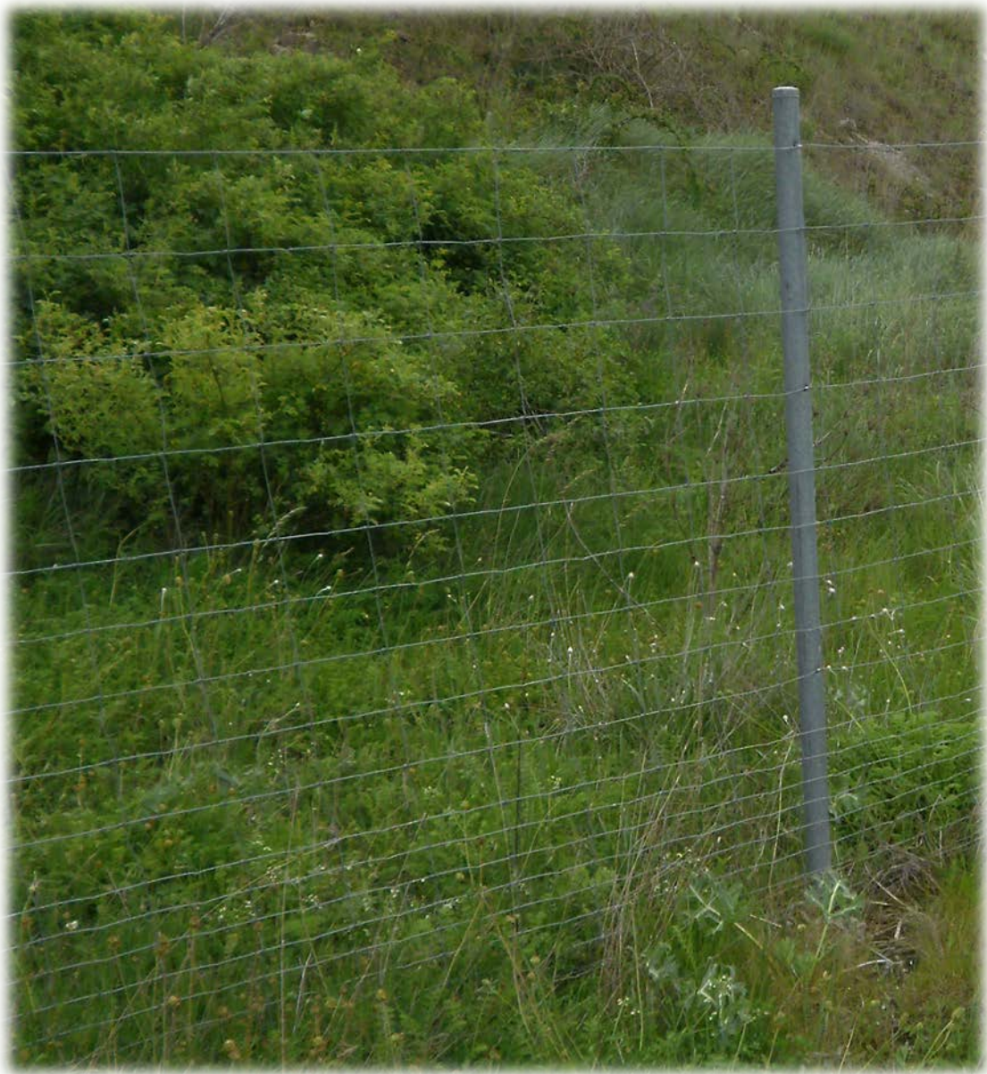
Figura 10. Vallado perimetral de malla cinegética (Fuente: elaboración propia).
