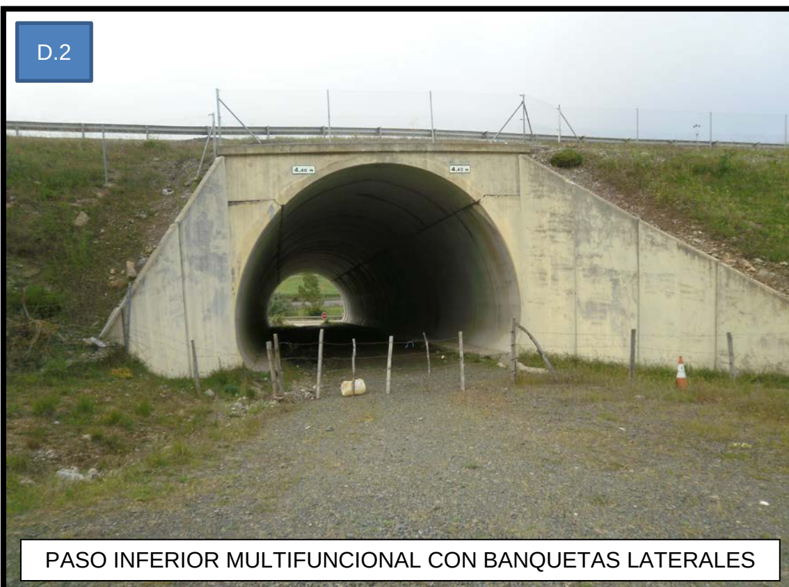
Figura 95. Diferentes estructuras inferiores transversales de la A-67 en Valdeprado del Río: A. Drenaje transversal de sección circular, B. Drenajes transversales de sección rectangular, C. Paso inferior multifuncional, D. Pasos inferiores multifuncionales con banquetas laterales (Fuente: elaboración propia).
