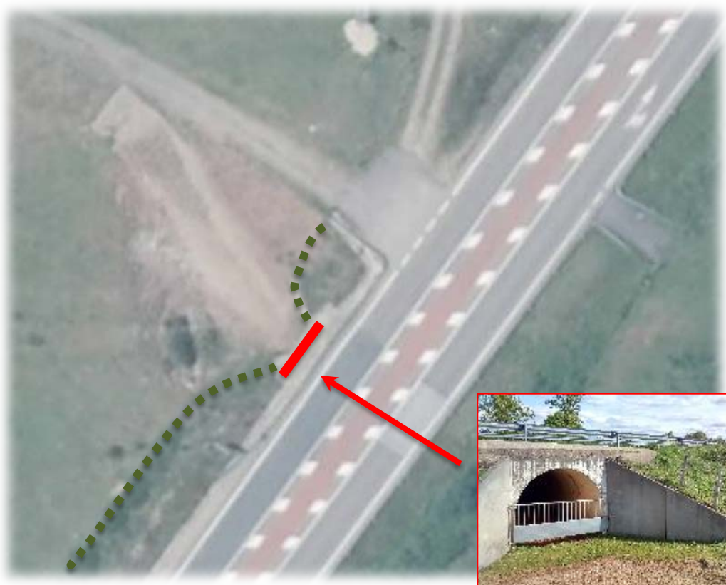
Figura 76. Estado actual del cerramiento del paso inferior de fauna situado en el PK 9.300 de la carretera CA- 171, Campoo de Yuso (Fuente: elaboración propia).
