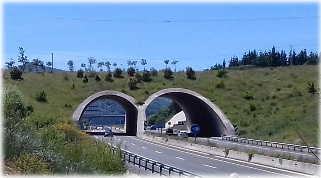
Figura 1. Paso superior multifuncional en la autovía de la Meseta A-67, Molledo, Cantabria (Fuente: elaboración propia).
