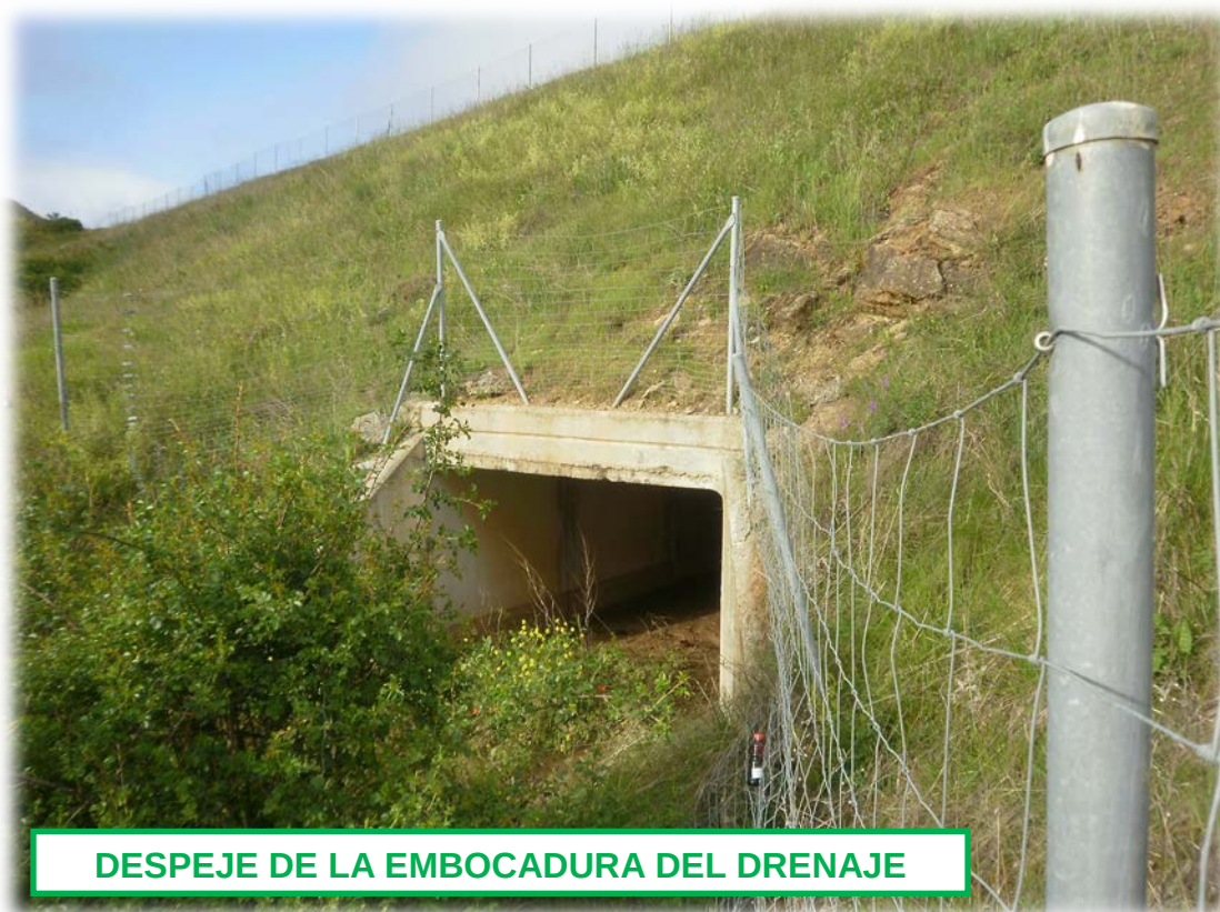
Figura 100. Drenajes transversales de las A-67 con vegetación en sus entradas (Fuente: elaboración propia).
