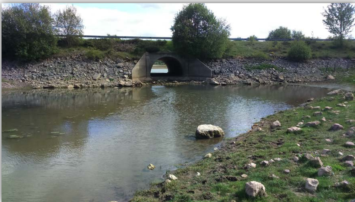
Figura 73. Vistas por ambos lados del paso inferior de agua de la carretera CA-171 (Fuente: elaboración propia).
