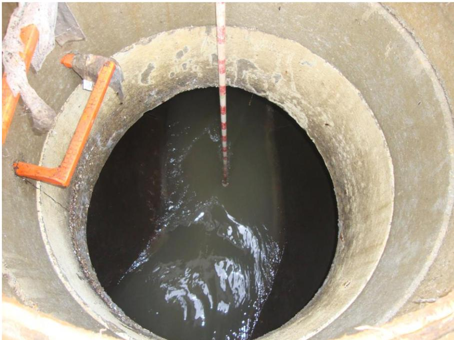
Tabla 7.7. Toma de datos para calibración hidráulica del modelo (07/02/17)
