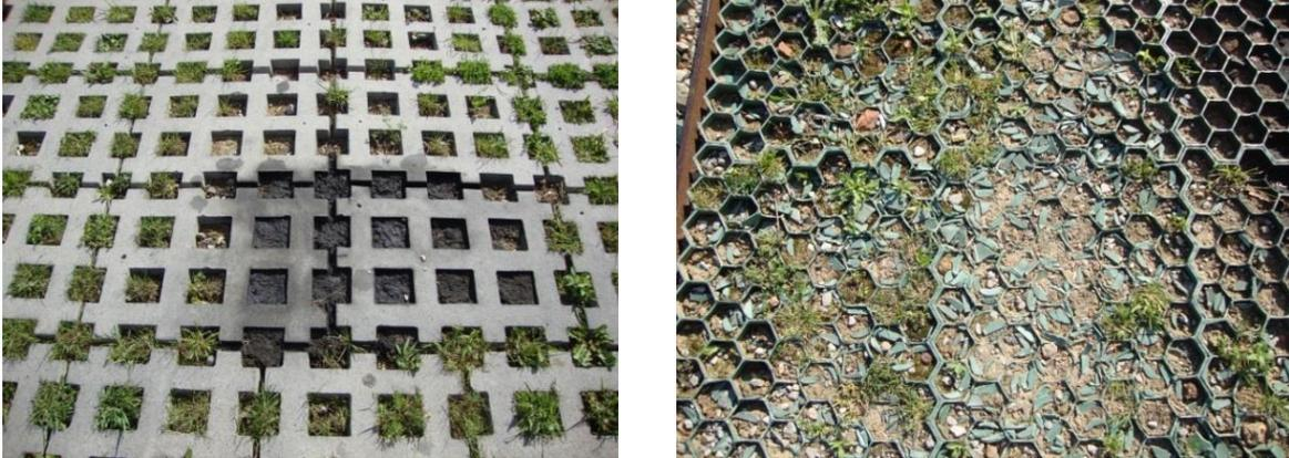
Estos tipos de pavimentos pueden sustituir a los pavimentos convencionales en zonas de aparcamiento, vías de tráfico ligero y arcenes, siempre y cuando se aseguren otras condiciones como la permeabilidad del suelo, la ausencia de grandes pendientes o la calidad de las aguas subterráneas. No se aconseja su uso en climas fríos o áridos, ni en aquéllos con un alto grado de erosión eólica, dado que la congelación del agua y los sedimentos transportados por el viento pueden arruinar el pavimento.
