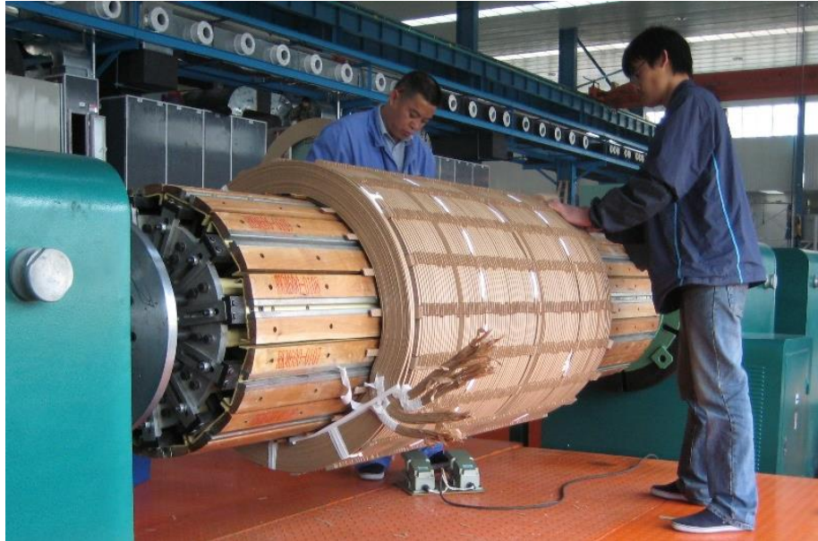
Figura 2.17. Proceso de bobinado de un transformador. (Fuente: [35]).
