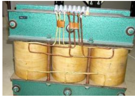
Figura 2.12. Transformador Trifásico en columna (Fuente: [15]).
