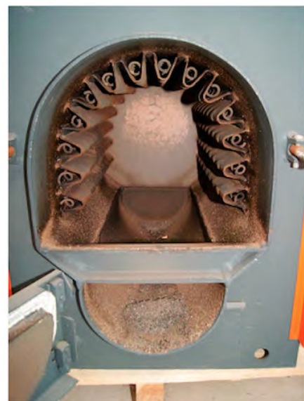
Ilustración 4: Intercambiador de calor. Fuente: Fundación laboral de la construcción.
