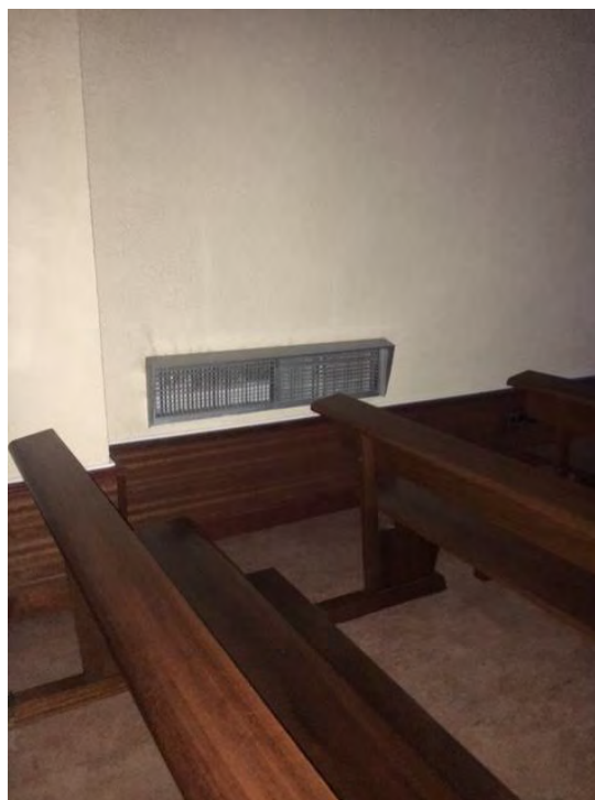
Ilustración 18: Rendijas por las que se expulsa el aire caliente en diferentes zonas del colegio. Fuente: Elaboración propia.
