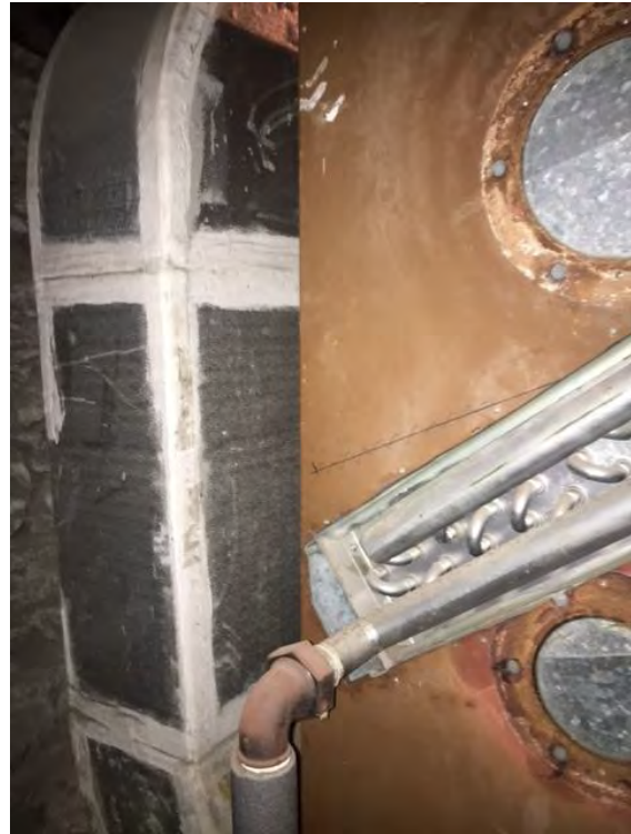
Ilustración 15: Llegada del tubo al serpentín. Fuente : Elaboración propia.
