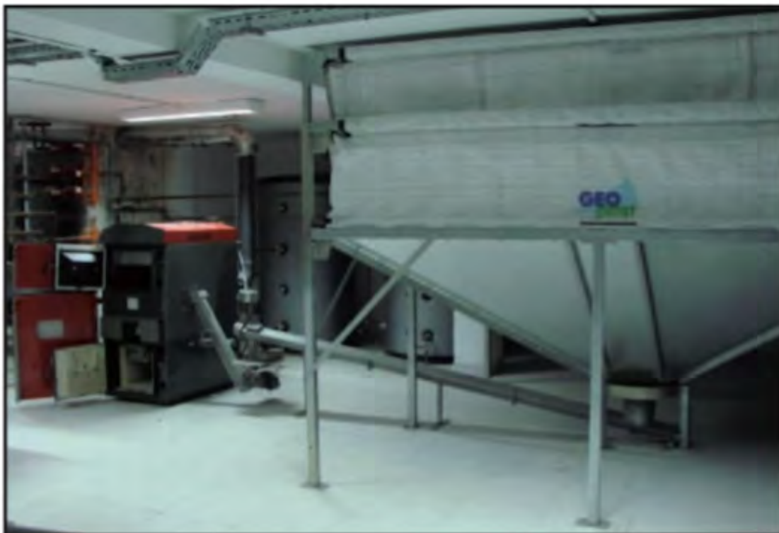
Ilustración 10: Silo de lona y alimentación a caldera. Fuente: IDAE
