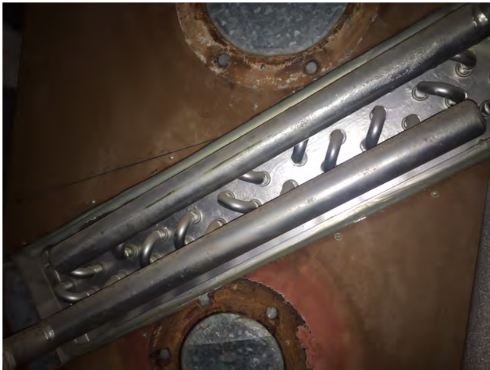
Ilustración 16: Serpentín. Fuente: Elaboración propia.
