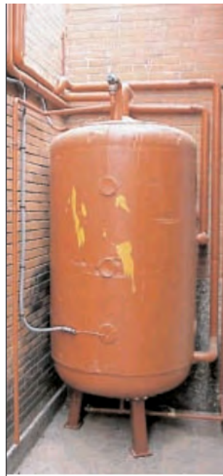
Ilustración 16: Imagen de un tanque de almacenamiento de una vivienda. Fuente IDAE
