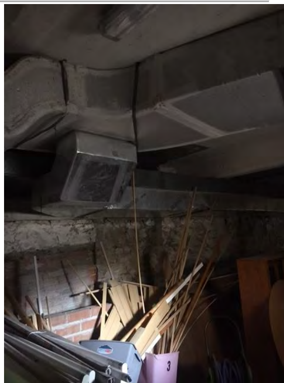
Ilustración 17: Tubo por el que una vez el agua que conduce el serpentín es calentada sale en forma de aire caliente recorriendo zonas del edificio. Fuente: Elaboración propia.
