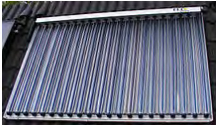
Ilustración 11: Captador solar de vacío. Fuente: Caloryfrio
