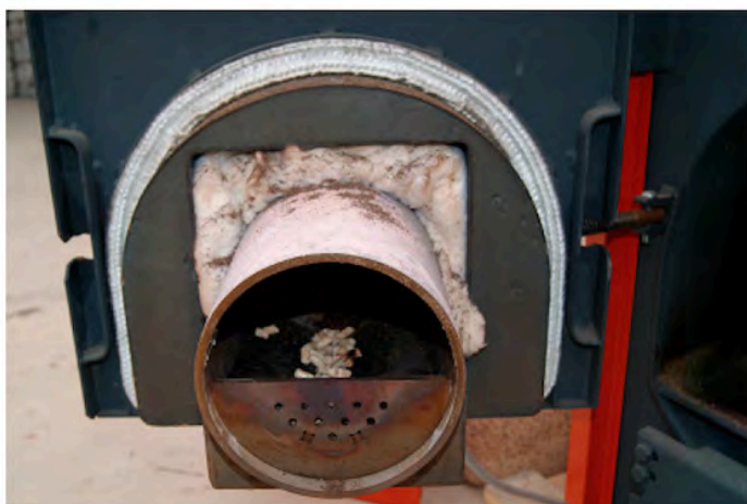
Ilustración 5: Quemador de caldera de pellets. Fuente: Fundación laboral de la construcción.
