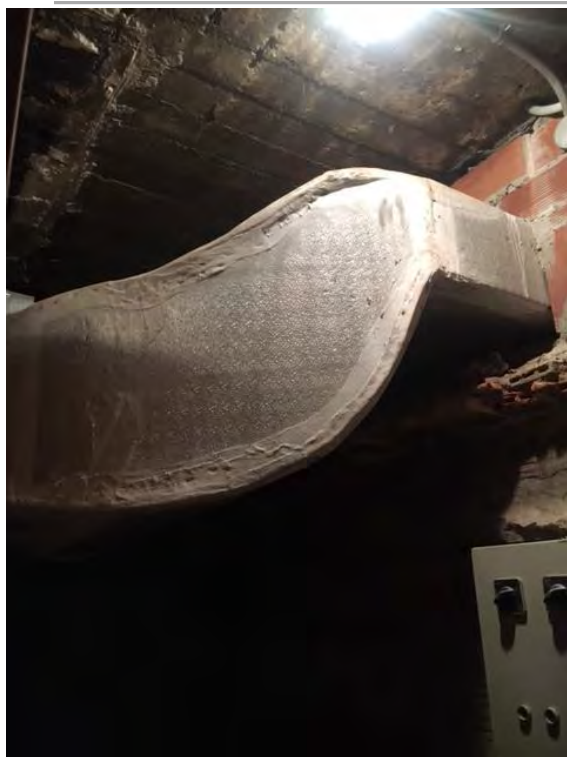
Ilustración 17: Tubo por el que una vez el agua que conduce el serpentín es calentada sale en forma de aire caliente recorriendo zonas del edificio. Fuente: Elaboración propia.
