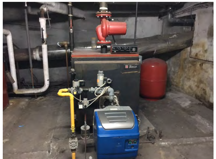
Ilustración 10: Imagen de la caldera 1 y 2 de la sala. Fuente: Elaboración propia.
