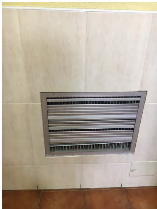
Ilustración 18: Rendijas por las que se expulsa el aire caliente en diferentes zonas del colegio. Fuente: Elaboración propia.
