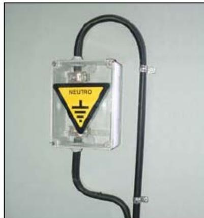
*Figura 4: Caja de seccionamiento de Neutro*
