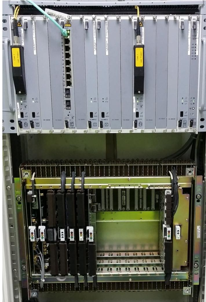
Figura 18. Equipo SDH + PDH Nokia Marconi STM-1 (equipos existentes en la línea verde fina de la Figura 20).
