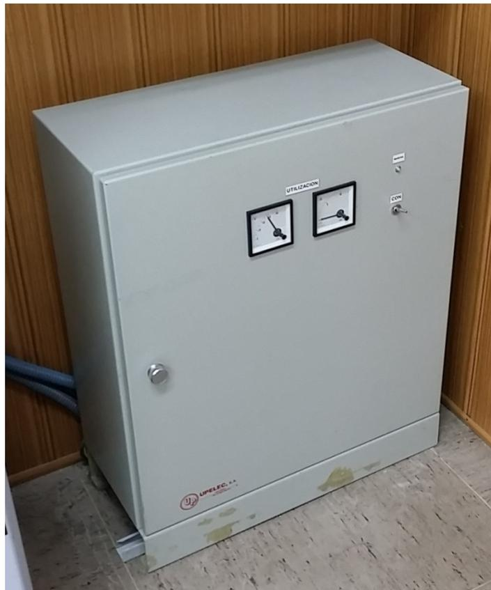
Figura 32. Sistema rectificador UPELEC.
