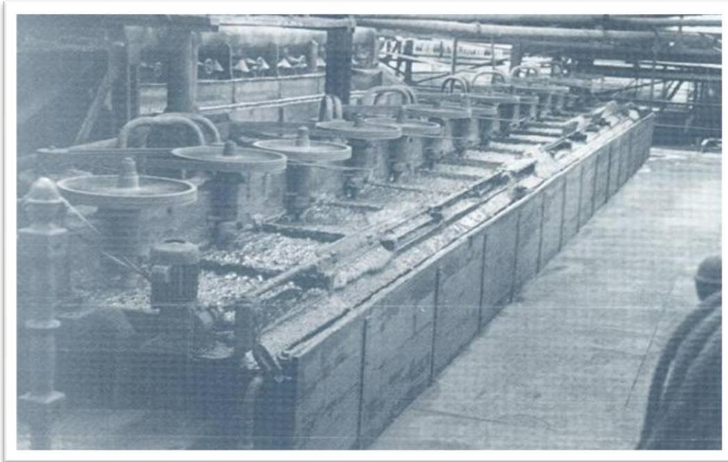
**Fig. n° 44- Nuevo lavadero de flotación de Reocín. Año 1984**
