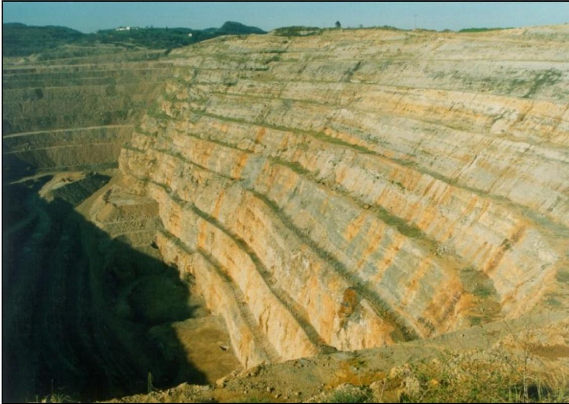
**Fig. nº 17- Deslizamiento de la pared de la corta (2003).**
