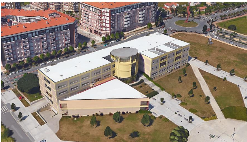
Ilustración 28 Edificio y alrededores. Google Earth.
