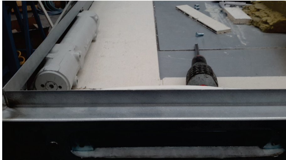
Figura 6-10. Preparación del cierrapuertas en el prototipo a escala real
