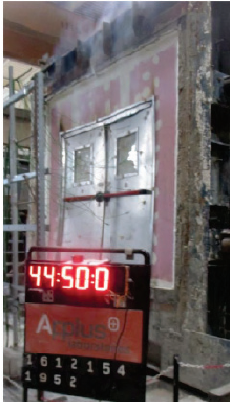
Figura 8-48. Ensayo de fuego 2 hojas. Estado de la muestra transcurridos los 44 minutos de ensayo
