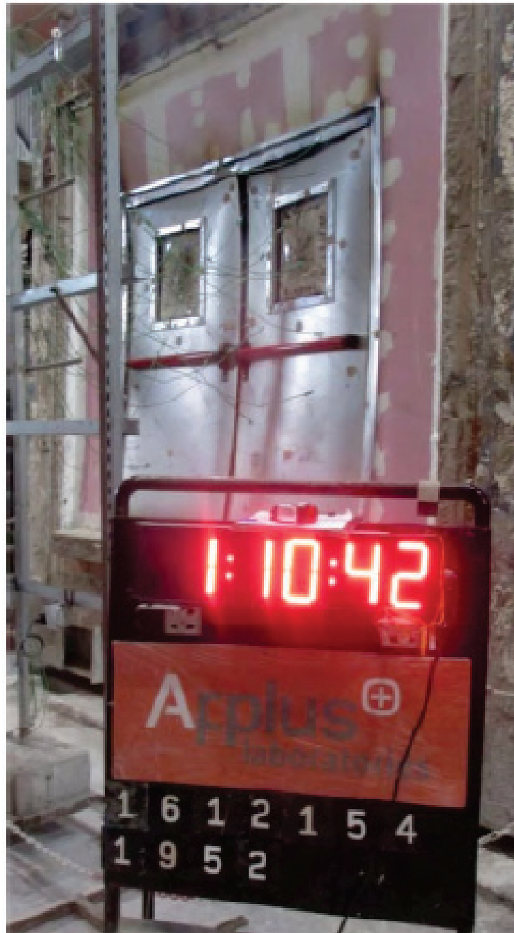
Figura 8-50. Ensayo de fuego 2 hojas. Estado de la muestra transcurridos los 70 minutos de ensayo
