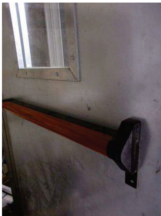
Figura 8-61. Ensayo de durabilidad. Detalle del dispositivo antipánico (hoja pasiva)
