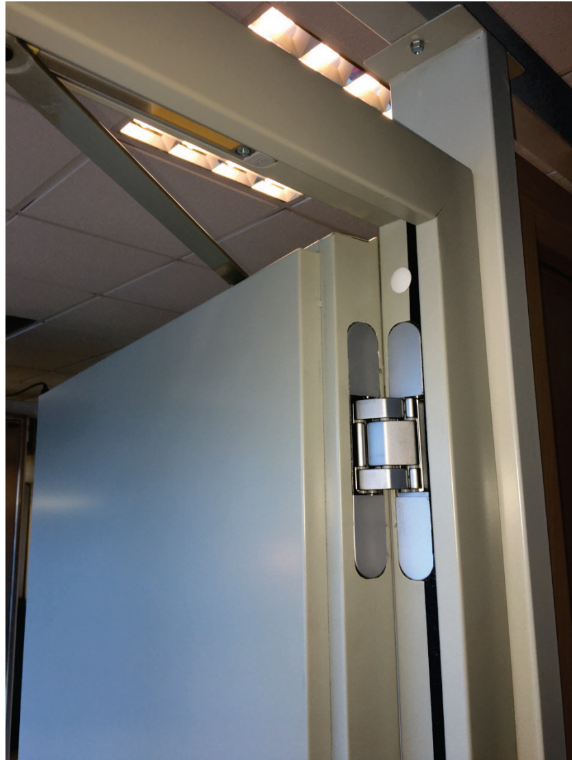
Figura 6-20. Detalle de la bisagra oculta. Exposición
