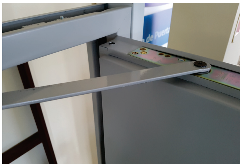
Figura 6-21. Detalle del cierrapuertas oculto. Exposición
