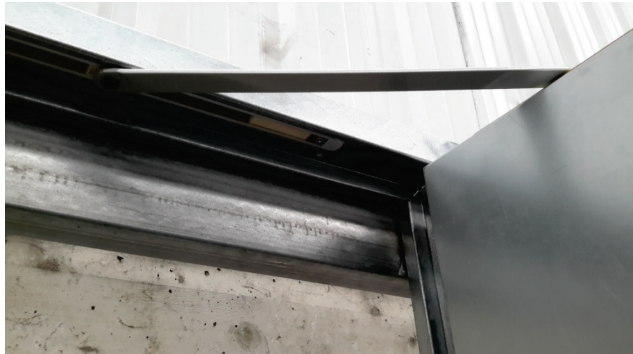
Figura 6-11. Apariencia del cierrapuertas oculto en el prototipo a escala real
