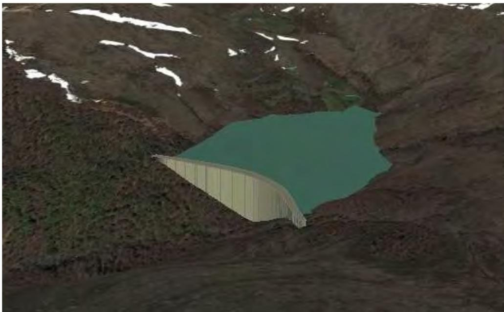
Ilustración 5: Presa superior arco gravedad, visión aérea. Elaboración propia.
