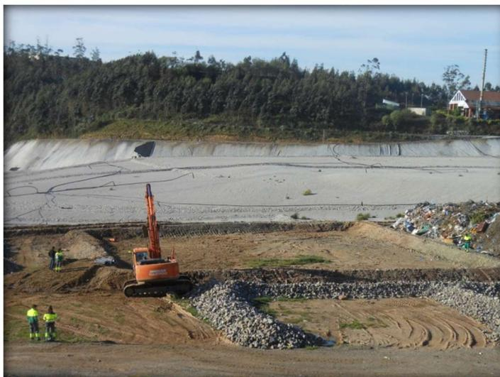
*Imagen 6.2. Talud perimetral de la celda experimental.*
