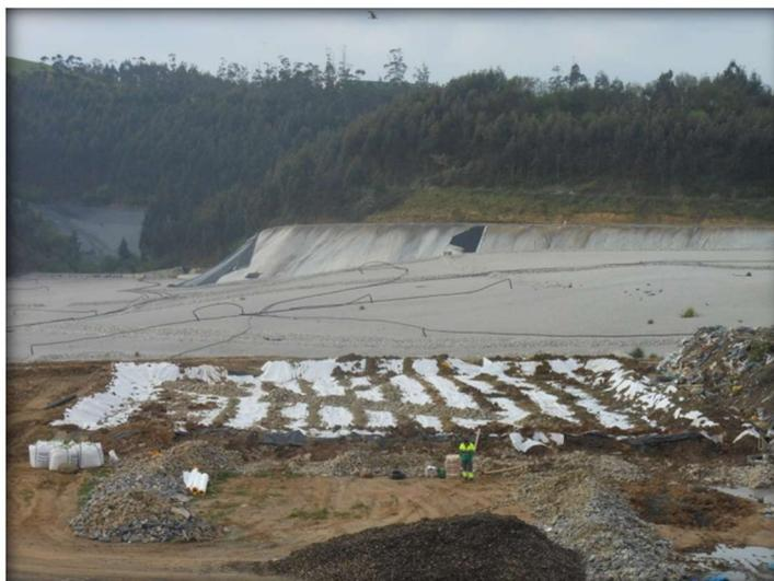
*Imagen 6.4. Aspecto de la celda impermeabilizada.*
