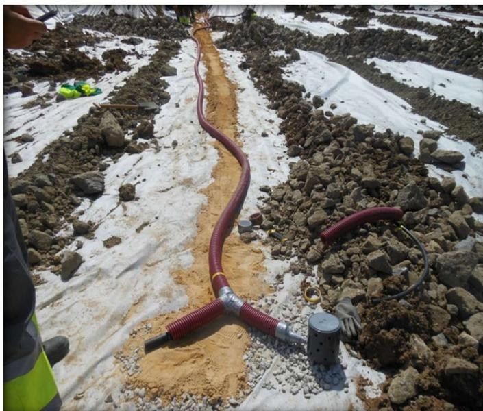
*Imagen 6.5. Colocación de uno de los piezómetros y tomamuestras.*
