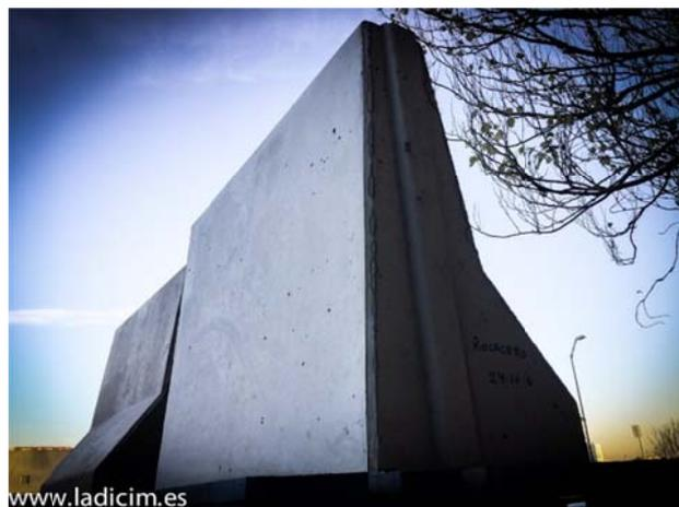
*Fig 2.1.3 El hormigón es un tipo de material compuesto reforzado con partículas. Las partículas de arena y grava se aglomeran en una pasta de cemento hidratada, lo que, al endurecerse, forma un material barato, duradero y con buena resistencia a compresión [7].*
