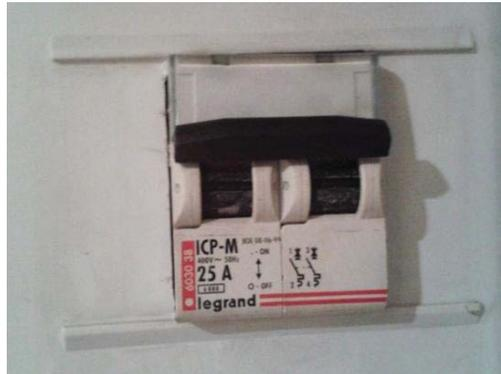
Fig.1. ICP (Interruptor de Control de Potencia) de la vivienda.
