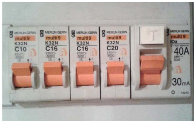
Fig.3. Interruptores automáticos de cada circuito y el interruptor diferencial.
