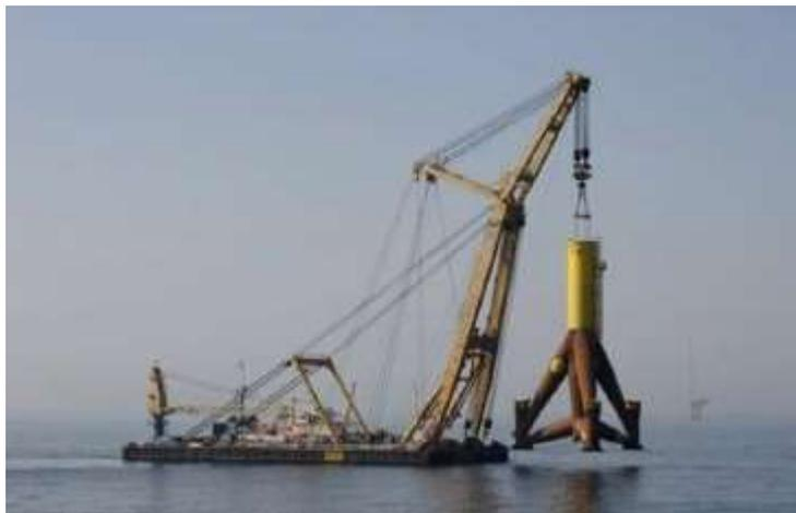
Figura 23: Instalación de una estructura de trípode (Fuente: García, 2013)
