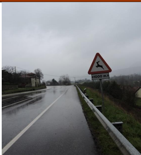
Figura 207.- Inicio del TAAF en la actualidad en el pk 300 y señalización (foto: propia).
