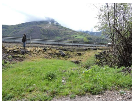
Figura 301.- Posible acceso maquinaria desde la AP-66, lado este (foto: propia).
