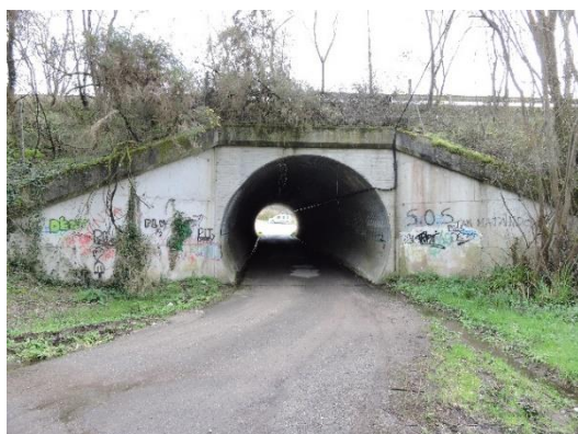
Figura 195.- Paso inferior próximo al pk 17 (foto: propia).
