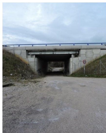
Figura 213.- Paso inferior de la autovía A-8 paralelo al TAAF (foto: propia).
