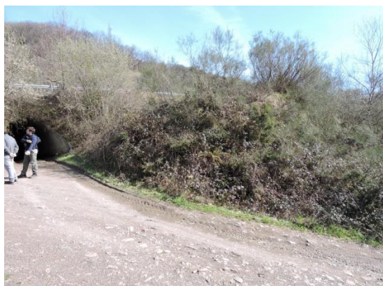
Figura 292.- Terraplén en lado oeste (foto: propia).
