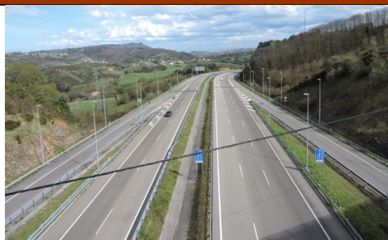
Figura 219.- Aspecto general del TAAF (foto: propia).
