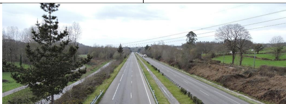
Figura 190.- Aspecto general del tramo en torno al pk 17 (foto: propia).
