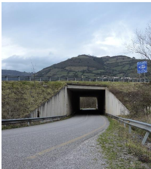
Figura 191.- Paso inferior próximo al pk 11 (foto: propia).
