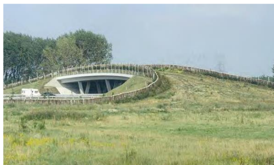
Figura 27.- Ejemplo de pendientes de acceso suaves a un paso de fauna (fuente: IUELL y col. 2003).
