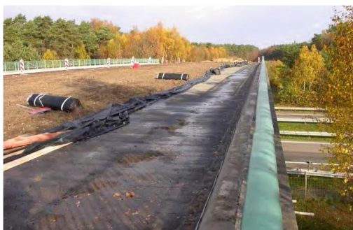
Figura 26.- Construcción de drenaje en un paso de fauna (fuente: MAGRAMA 2015).
