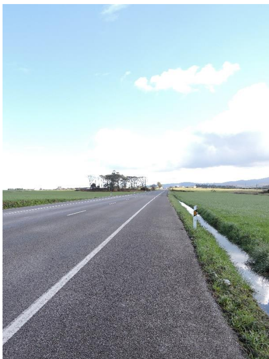
Figura 201.- Aspecto general del TAAF (foto: propia).
