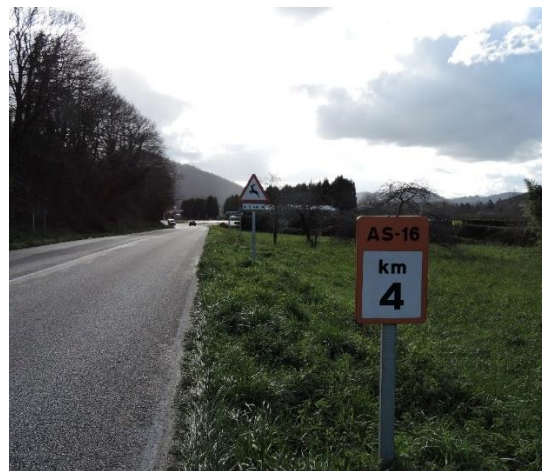
Figura 246.- Inicio del TAAF en el pk 4 (foto: propia).
