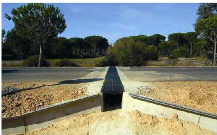
Figura 55.- Acondicionamiento para paso de anfibios en la HF-6248 (fuente: JUNTA DE ANDALUCÍA 2010).
