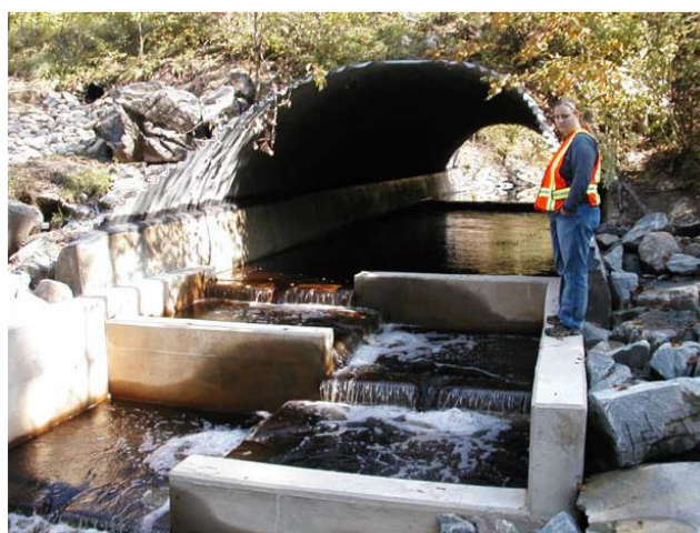
Figura 53.- Escala para salmonidos para acceder a un drenaje adaptado (fuente: MAINE DEPARTMENT OF TRANSPORTATION 2008).
