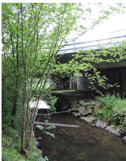
Figura 193.- Viaducto en el pk 12+300 (foto: propia).
