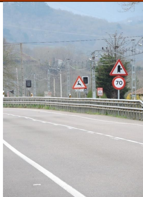
Figura 252.- Señalización (foto: propia).
