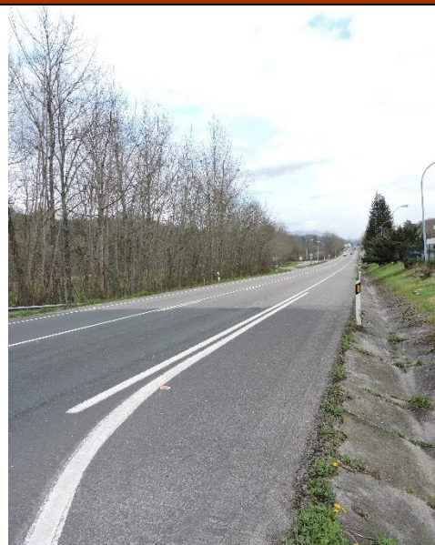
Figura 227.- Aspecto general del TAAF (foto: propia).
