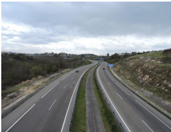
Figura 171.- Aspecto general del tramo (foto: propia).
