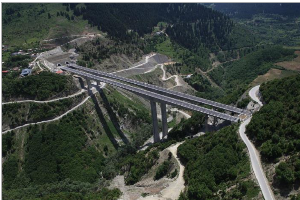
Figura 270.- Autovía Egnatia (Grecia) (fuente: Egnatia Odos S.A. en CSIL, 2012).
