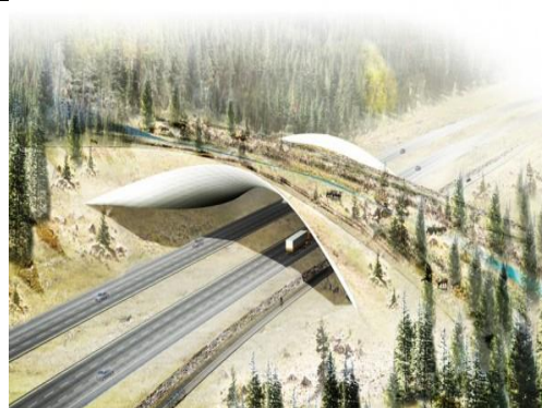
Figura 17.- Diseño específico de un ecoducto mediante un sistema de membrana (fuente: ZWARTS y JANSMA 2010).
