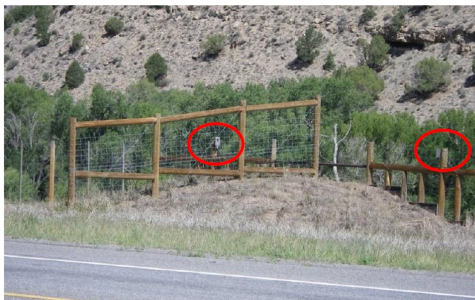
Figura 59.- Rampa de tierra de escape para ciervos, dotada de cámaras de seguimiento (círculos rojos), en la Highway 550 (Colorado, USA) (fuente: SIEMERS y col. 2015).
