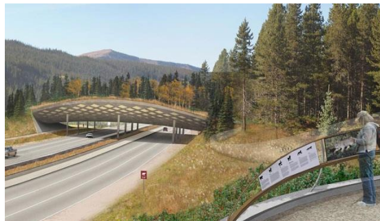
Figura 24.- Diseño específico de un paso de fauna mediante un sistema romboidal (fuente: THE OLIN STUDIO 2010).
