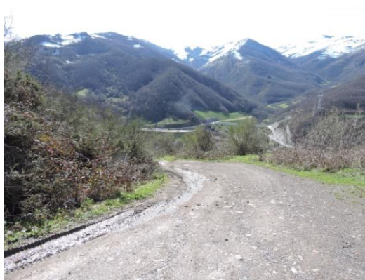
Figura 289.- Pista de acceso, lado oeste, y obras del AVE al fondo del valle (foto: propia).
