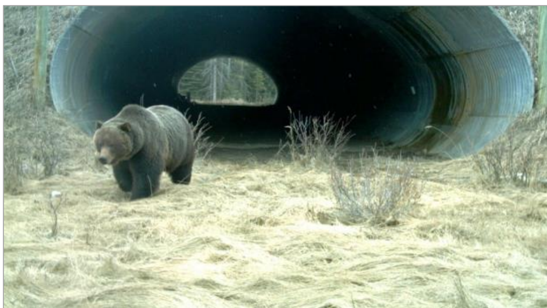
Figura 280.- Un oso grizzly emerge de un paso tipo arco metálico multiplano en la Trans-Canada Highway en el Parque Nacional de Banff (fuente: highwaywilding.org).
