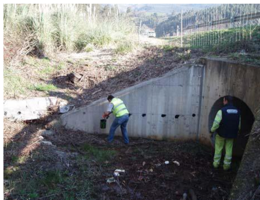
Figura 74.- Aplicación de un atrayente en un drenaje para que actúe como paso de fauna (fotografía cortesía de Juan Antonio Ruiz de Villa).
