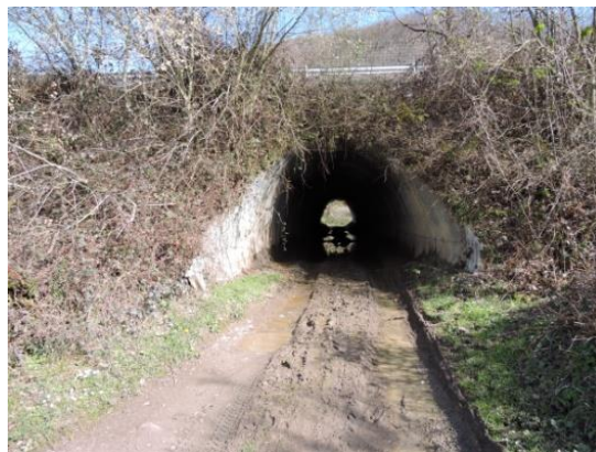
Figura 291.- Vista del paso, lado este (foto: propia).
