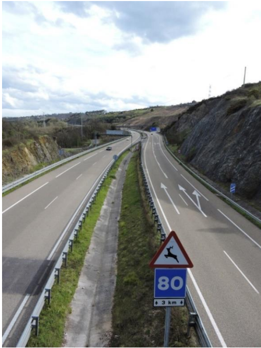
Figura 169.- Señalización de advertencia en el tramo (foto: propia).
