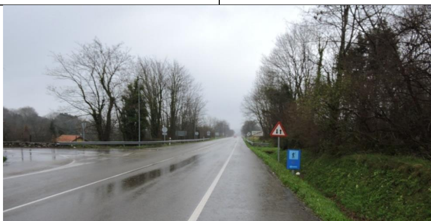
Figura 209.- Aspecto general del TAAF (foto: propia).
