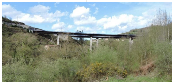
Figura 168.- Viaducto (vano 280 m) inmediatamente posterior al tramo (foto: propia).
