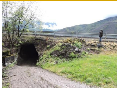
Figura 299.- Vista del paso, lado este Vista del paso, lado oeste (foto: propia).
