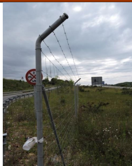
Figura 208.- Vallado con voladizo en la A-8 (paralela a la N-634) (foto: propia).
