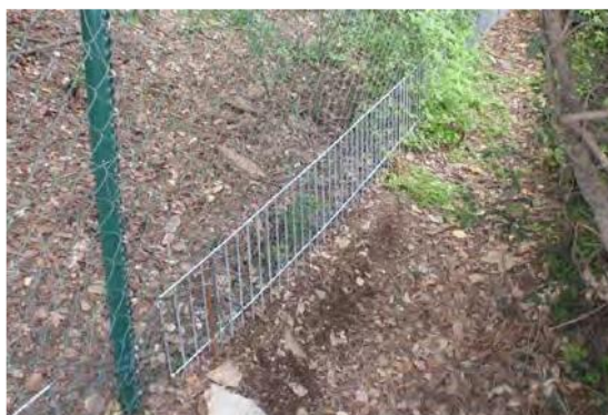
Figura 57.- Detalle del refuerzo con malla rígida electrosoldada (fuente: MAGRAMA 2015).
