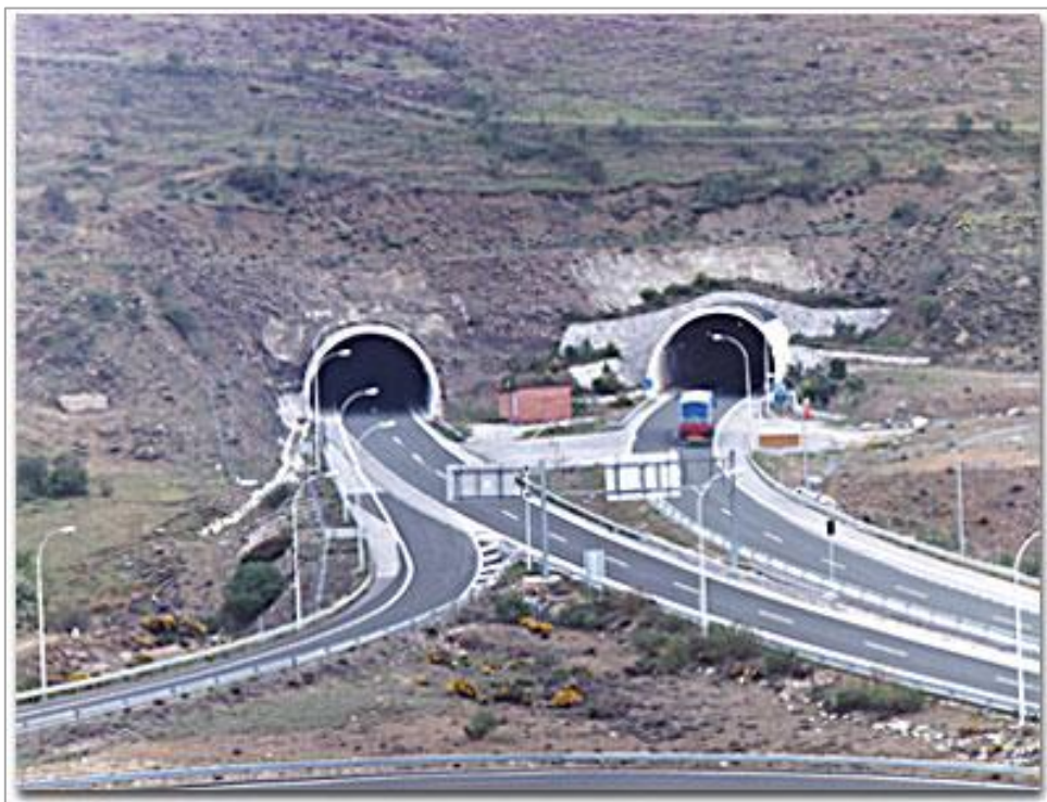
Figura 264.- Túneles en la AP-66 (fuente: AUCALSA 2015).
