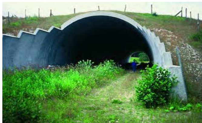
Figura 41.- Paso inferior mixto abovedado (fuente: IUELL 2003)
