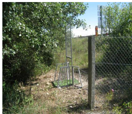
Figura 60.- Puerta de escape para jabalíes en la A51 de Francia (fuente: BUTON y BEROUD 2013).
