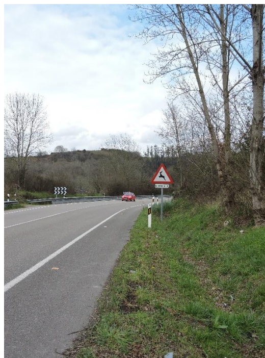
Figura 255.- Aspecto general del TAAF (foto: propia).
