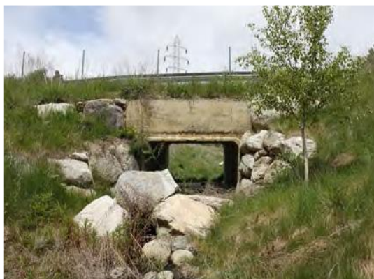
Figura 46.- Acondicionamiento de acceso para conducir a los animales hacia el paso (fuente: MAGRAMA 2006).
