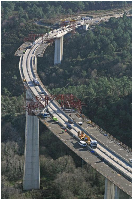
Figura 35.- Viaducto de grandes dimensiones en el vano que funciona como corredor ecológico (fuente: TORROJA y col. 2011).
