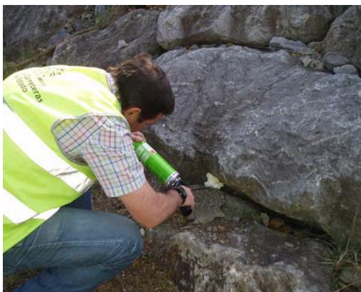
Figura 73.- Inserción de repelentes entre las rocas de una escollera (fotografía cortesía de Juan Antonio Ruiz de Villa).
