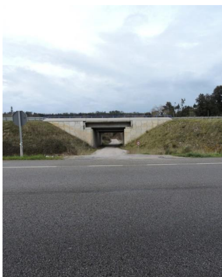
Figura 212.- Paso inferior de la autovía A-8 paralelo al TAAF (foto: propia).
