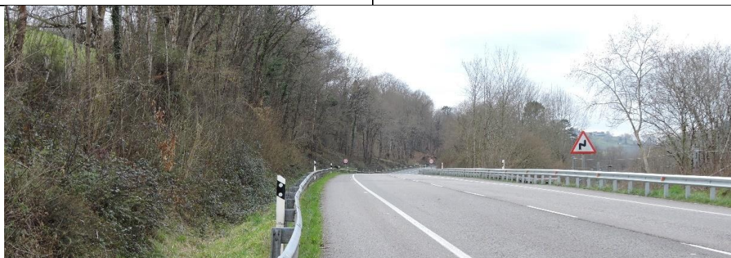
Figura 228.- Abundante vegetación arbolada en las márgenes del vial (foto: propia).
