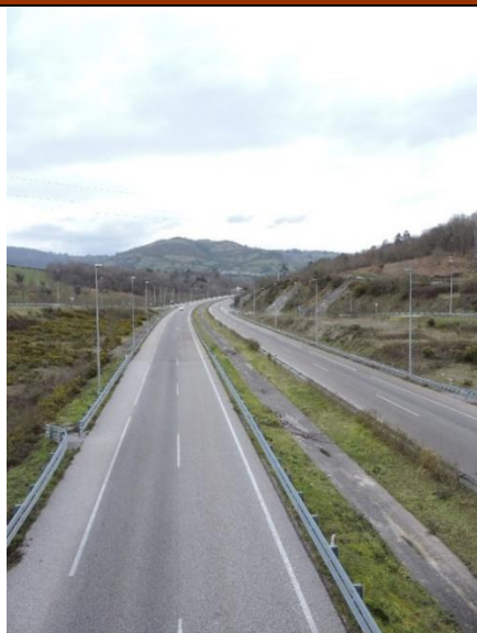
Figura 188.- Aspecto general del tramo en torno al pk 11 (foto: propia).
