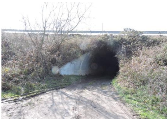
Figura 290.- Vista del paso, lado oeste (foto: propia).
