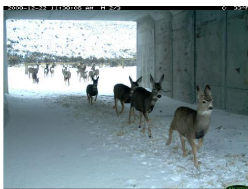
Figura 43.- Paso inferior mixto muy utilizado por la fauna debido a su escaso uso humano (fuente: WYOMING DEPARTMENT OF TRANSPORTATION 2010)
