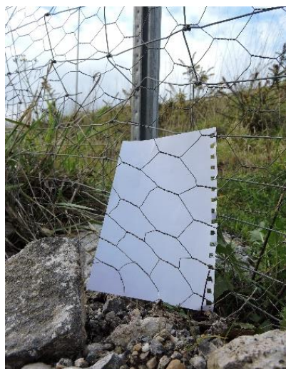
Figura 194.- Detalle de un tipo de refuerzo (foto: propia).
