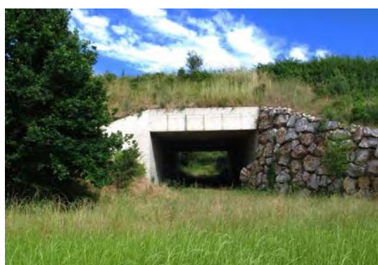
Figura 40.- Paso inferior de fauna bien acondicionado (fuente: MAGRAMA 2015).
