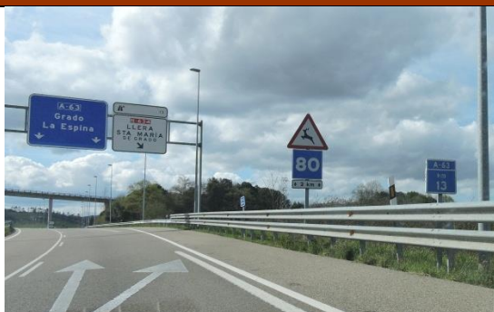
Figura 218.- Señalización, con recomendación de velocidad (foto: propia).
