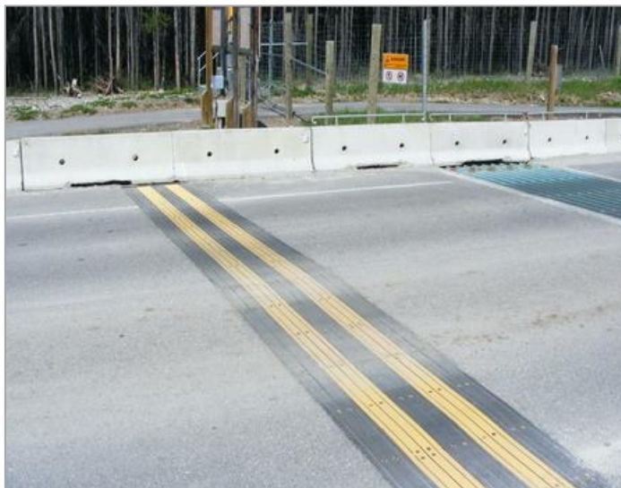
Figura 267.- Alfombra electrificada (o electromat) en un acceso a la autovía 93 North, en el Parque Nacional de Banff (fuente: PARKS CANADÁ, 2014).
