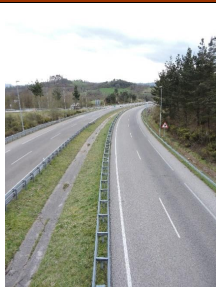
Figura 189.- Aspecto general del tramo en torno al pk 11 (foto: propia).
