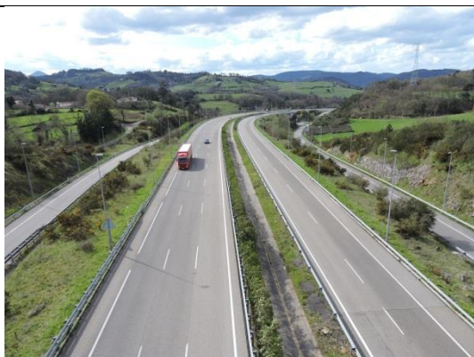
Figura 220.- Aspecto general del TAAF (foto: propia).
