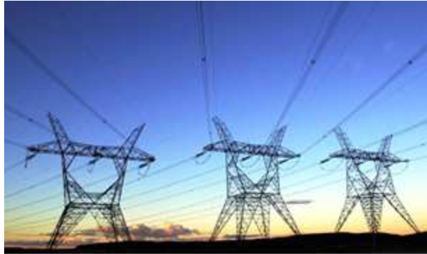
Figura 5 Transporte energía eléctrica en alta tensión. (DIELCA, 2014)
