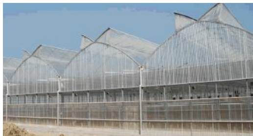
Imagen 4. 7. Construcción Invernadero Multitúnel
