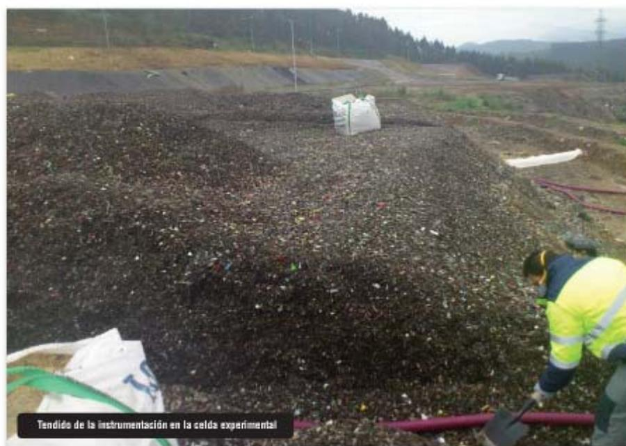
Tendido de la instrumentación en la celda experimental
