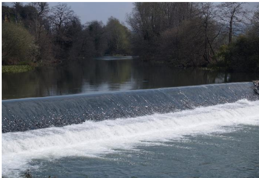
Fig 5. Vista frontal del azud existente.
