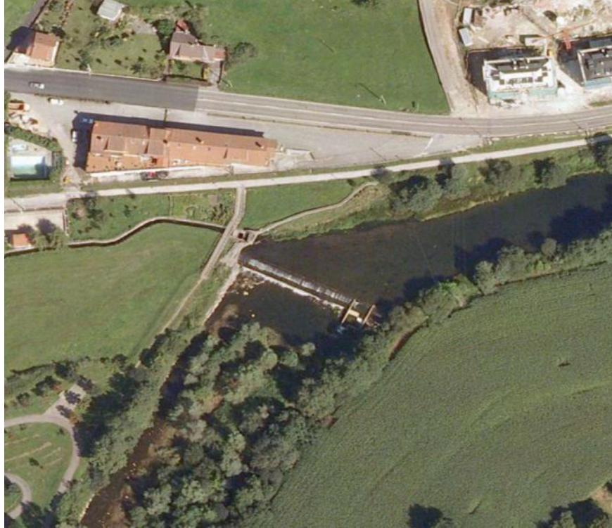
Fig 4. Vista aerea del azud existente.
