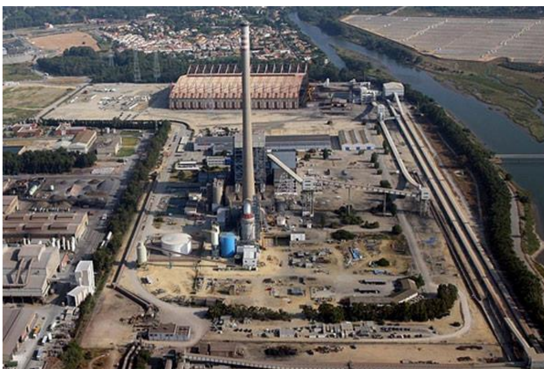
Figura 4. Central Térmica de Los Barrios (Cádiz). [4]
