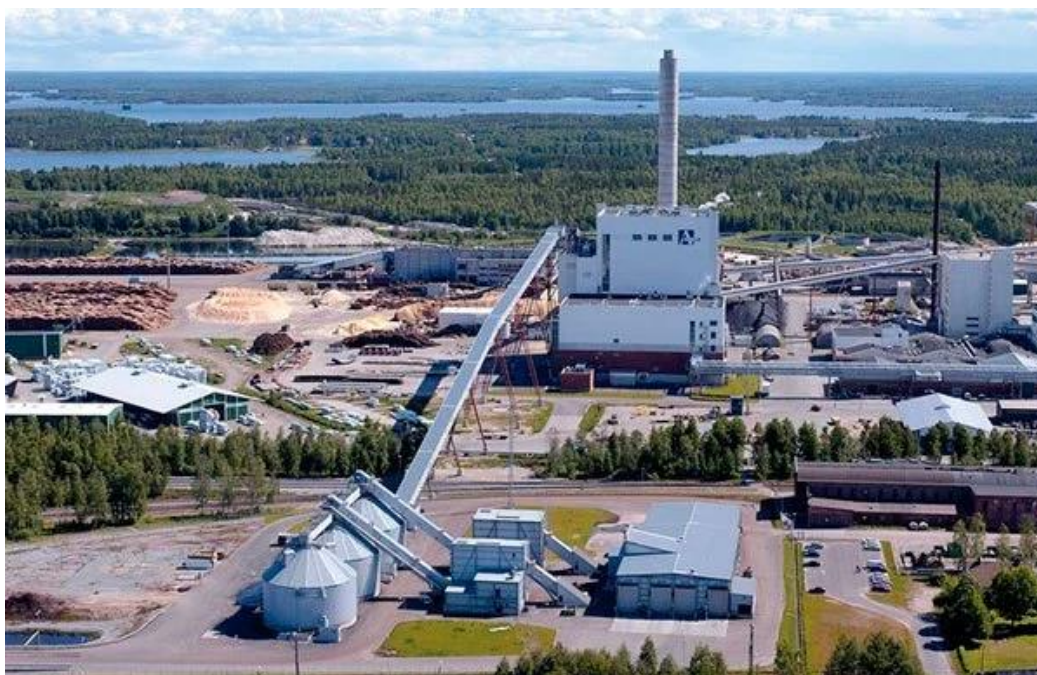
Figura 12. Central de biomasa de Alholmens Kraft (Finlandia). [9]
