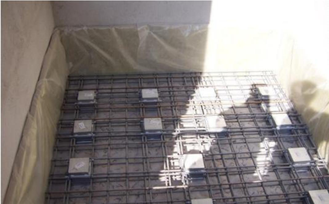
*Ilustración 5 Ejemplo de un sistema de losas flotantes*
