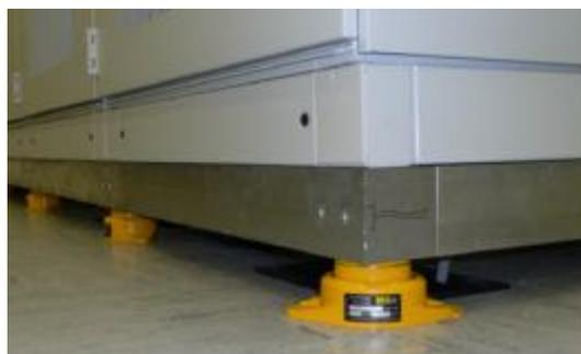
*Ilustración 1 Aislador tipo muelle*
