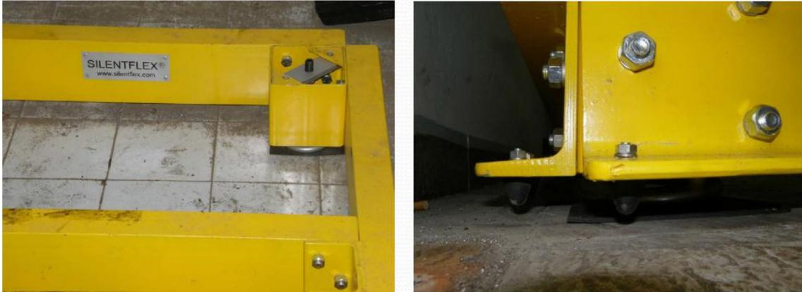
*Ilustración 3 Ejemplo de un marco metálico anti vibraciones*
