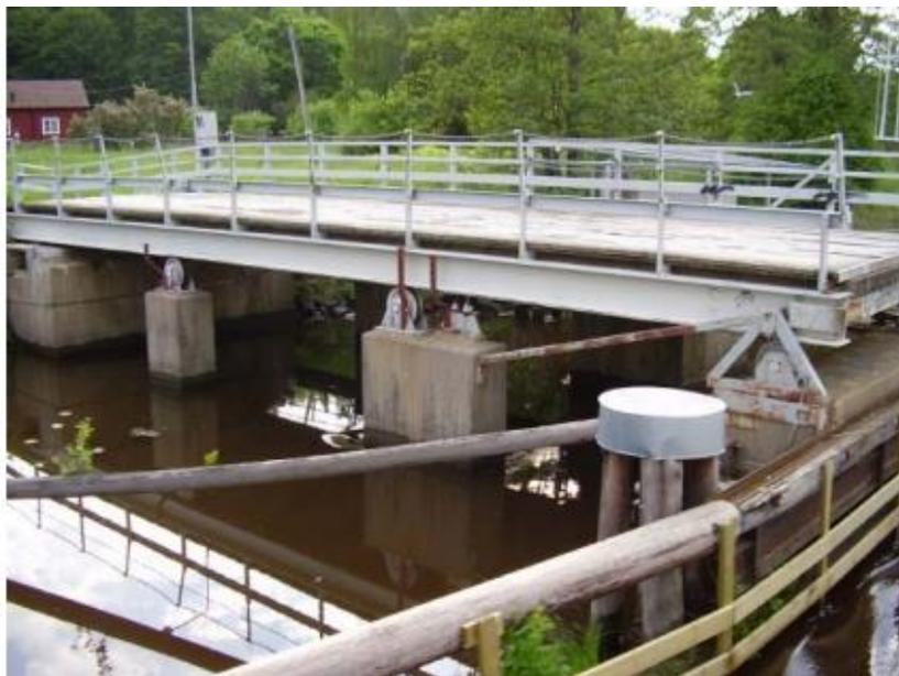
**Figura 25. Calzada sobre rodillos del puente retractable de Uppsala**
